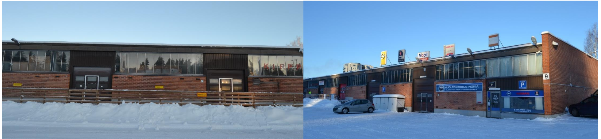
Rakennus 1:n julkisivuja eteläpuolelta ja itäpäädyistä. Julkisivu poikkeaa piirustuksista ovien osalta: piirustuksissa ovet on sijoitettu umpinaiisiin profiilipeltiosioihin vasemmalle. Rakennuksen ovet sijaitsevat kuitenkin ikkunallisten ovialementtien keskellä. Lisäksi ovien yläpuoliset osat ovat vitral-lasien sijasta profiilipeltiä.
