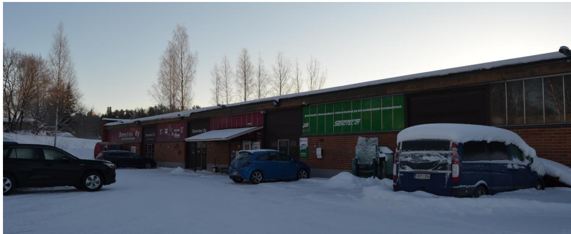
Rakennus 1:n julkisivuja pohjoispuolelta rakennuksen itäpäädyttä. Pohjoisella sivulla ovien yläpuoliset osat vastaavat alkuperäispiirustuksia. Itse ovet on toteutettu samanlaisina kuin eteläisivulla. Pohjoissivulle on myöhemmin tehty uusi ulko-ovi (2002) ja sen päälle katos.
