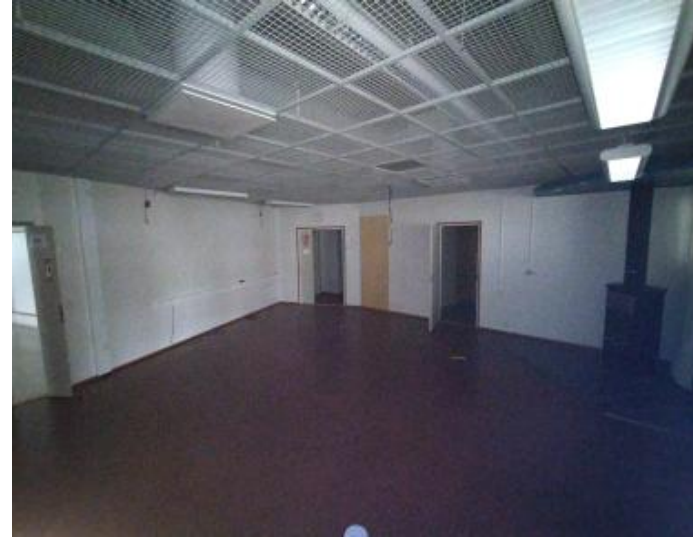
Kuva 77 4. kerroksen saunatilan takkahuone
