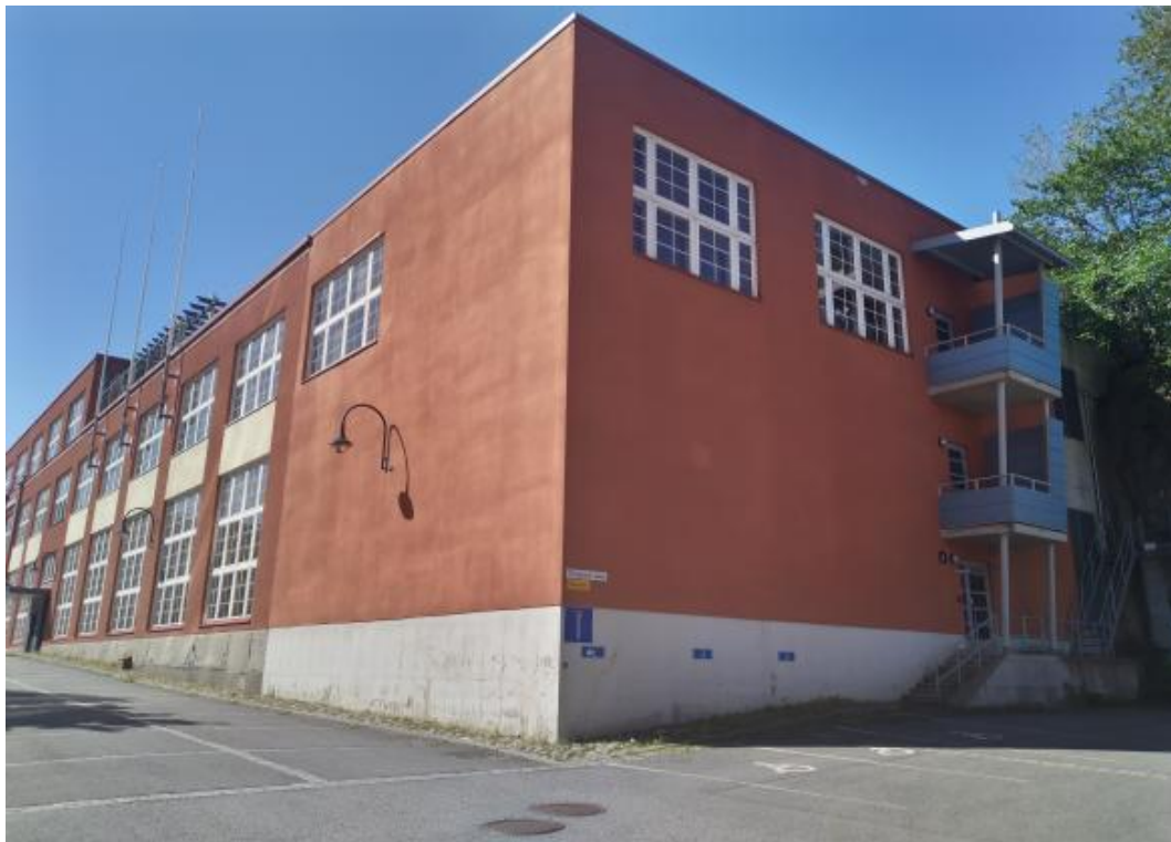
Kuva 60 Julkisivu itään, 1980-luvun lisäsiipi
