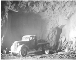
Kuva 7 Luolastoa louhitaan vuonna 1939 (Akseli Tampere).
