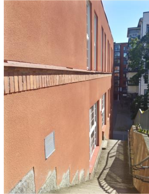
Kuva 59 Julkisivu länteen ulkoportaat
