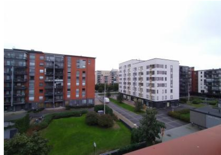
Kuva 86 näkymä etelään; kattoterassilta sisäpiha
