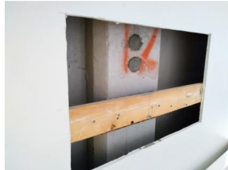
Kuva 63 Koteloidun pilarin näytteenottoaika
