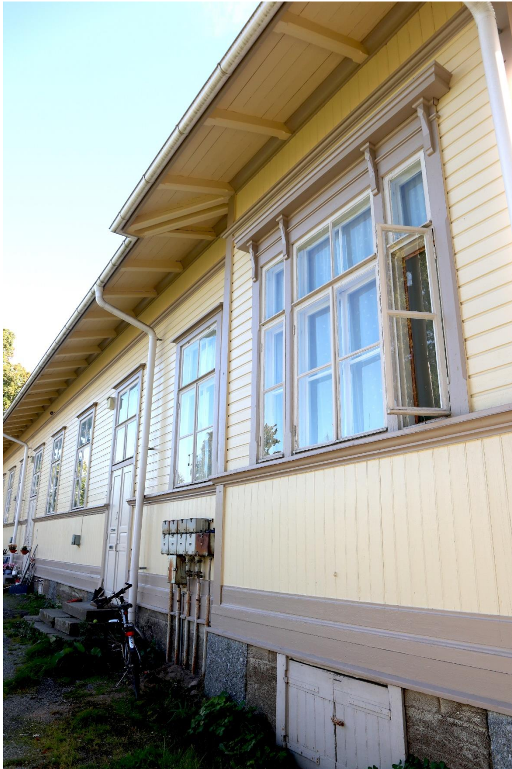
Kuva 31. Rakennuksen länsijulkisivu sisäpihan puolella. Valokuva syksyiltä 2020.
