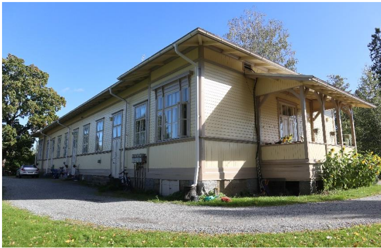
Kuva 28. Rakennuksen lounaiskulma. Valokuva syksyltä 2020.
