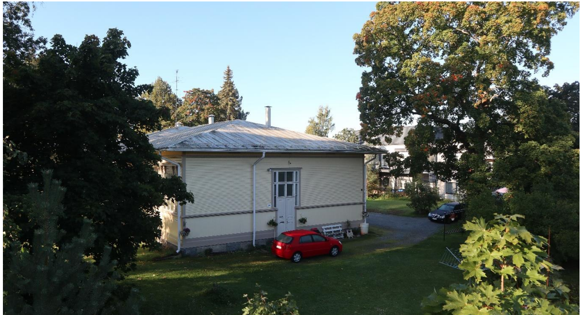
Kuva 29. Rakennuksen pohjoisjulkisivu. Valokuva syksyiltä 2020.
