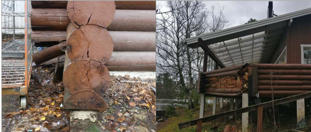
Terassin räystäät huonokuntoiset, rakennus on kärsinyt ilkivallasta
