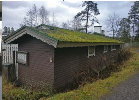
Maastonmuodot ovat keräävät lunta ja vettä rakennukset julkisivulle
