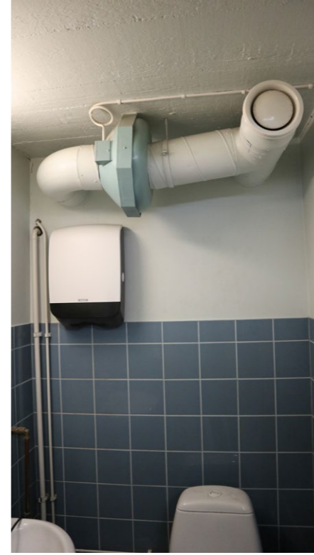
Vuonna 2002 toimistorakennuksen kokoushuoneen tilalle rakennettiin pukuhuone wc- ja suihkutiloineen.
