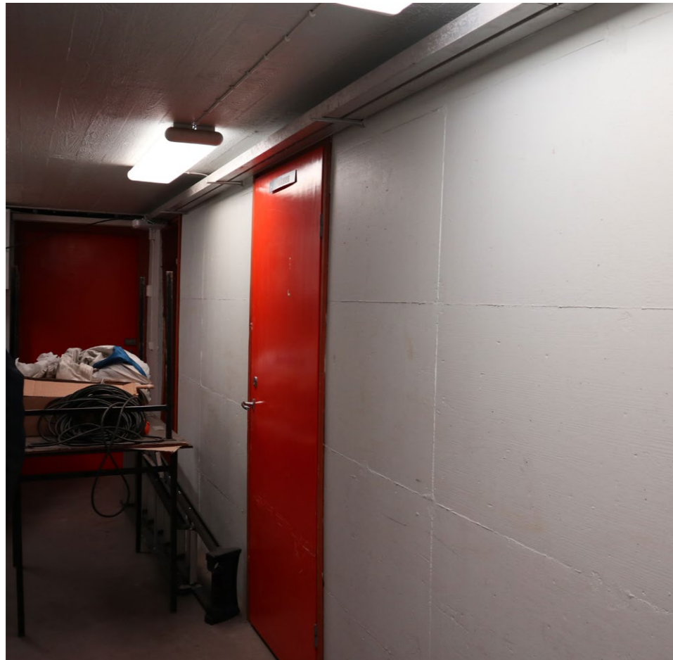
Betoniset lattiat on hierretty ja maalattu. Sisäseinissä ja -katoissa on niin ikään puhtaaksivalettu betonipinta valkoiseksi maalattuna. Punaiset teräsovet ja puukarmit tuovat väriä muutoin askeettisiin sisätiloihin.
