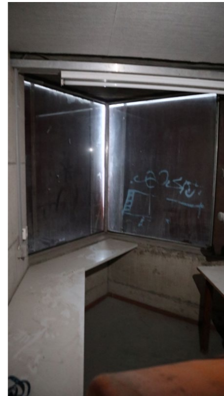
Radio- ja tv-selostamoiden seinissä ja katossa on akustikkalevyt.
