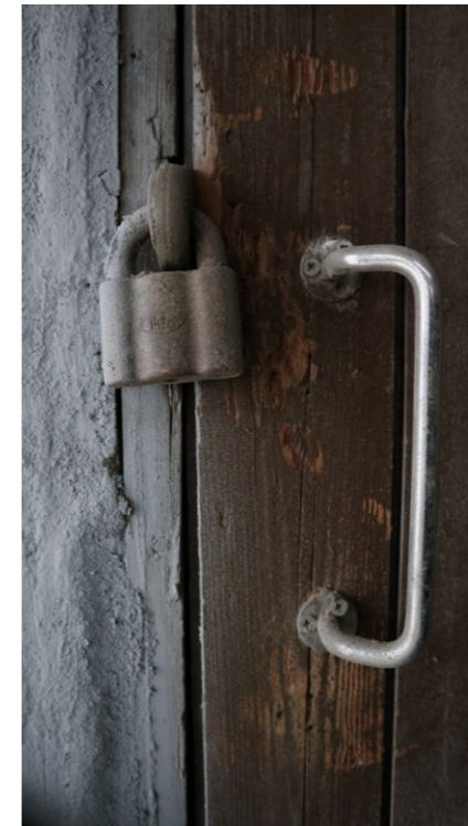
Ruskeissa mäntyulko-ovissa on lankavetimet ja Abloyn lukot. Myös toimistorakennuksen ja ajanottorinin välillä on ulko-ovi, koska torniosa oli alunperin ulkotilaa.
