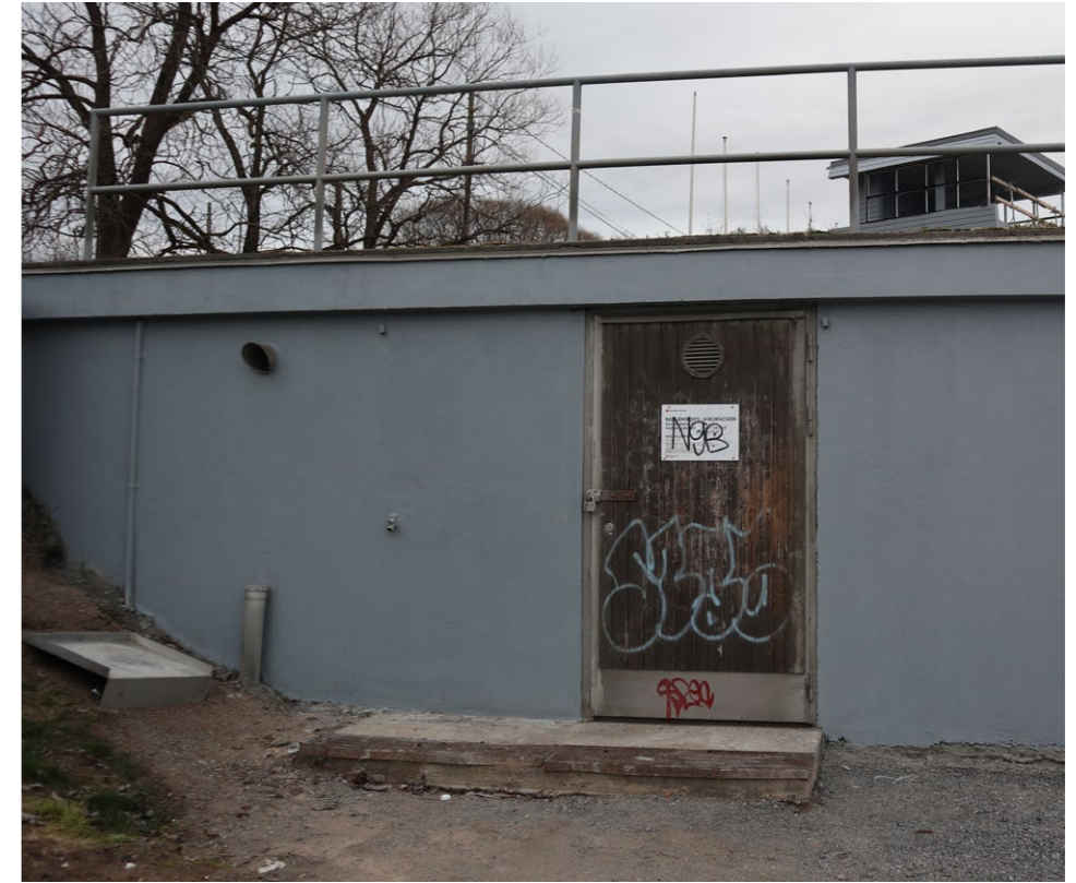
Itäisellä julkisivulla vasemman puoleinen ulko-ovi muurattiin umpeen pukuhuoneen rakentamisen yhteydessä vuonna 2002.
