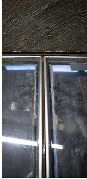
Toimistosiivessä on edelleen alkuperäiset yksinkertaiset 1970-luvun ikkunat alumiinikarmeineen.
