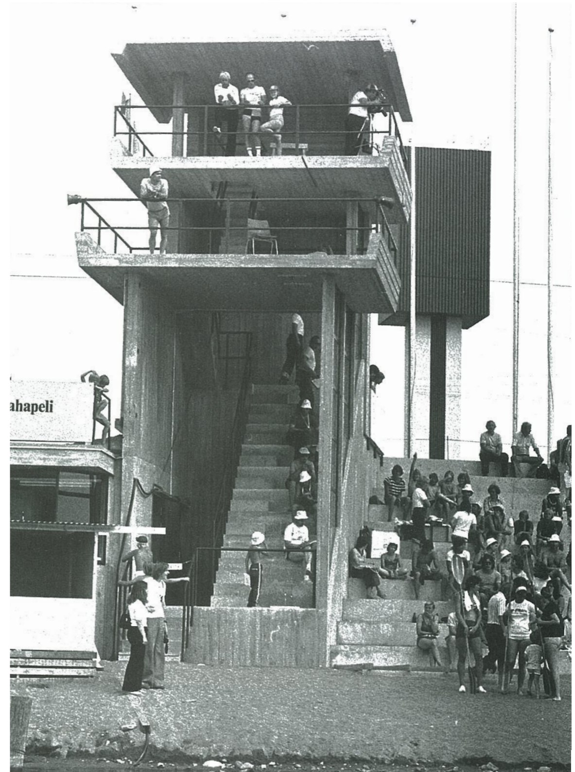
Kesäistä 1970-luvun tunnelmaa Kaukajärven stadionilta. Juuri rakennettu ajanottotorni oli ulkotilaa ja sirot teräskateet kehystivät betonista runkoa. Vasemmalla näkyy väliaikaiset kisatoimistot kilpailuja varten. Koivisto 1997.
