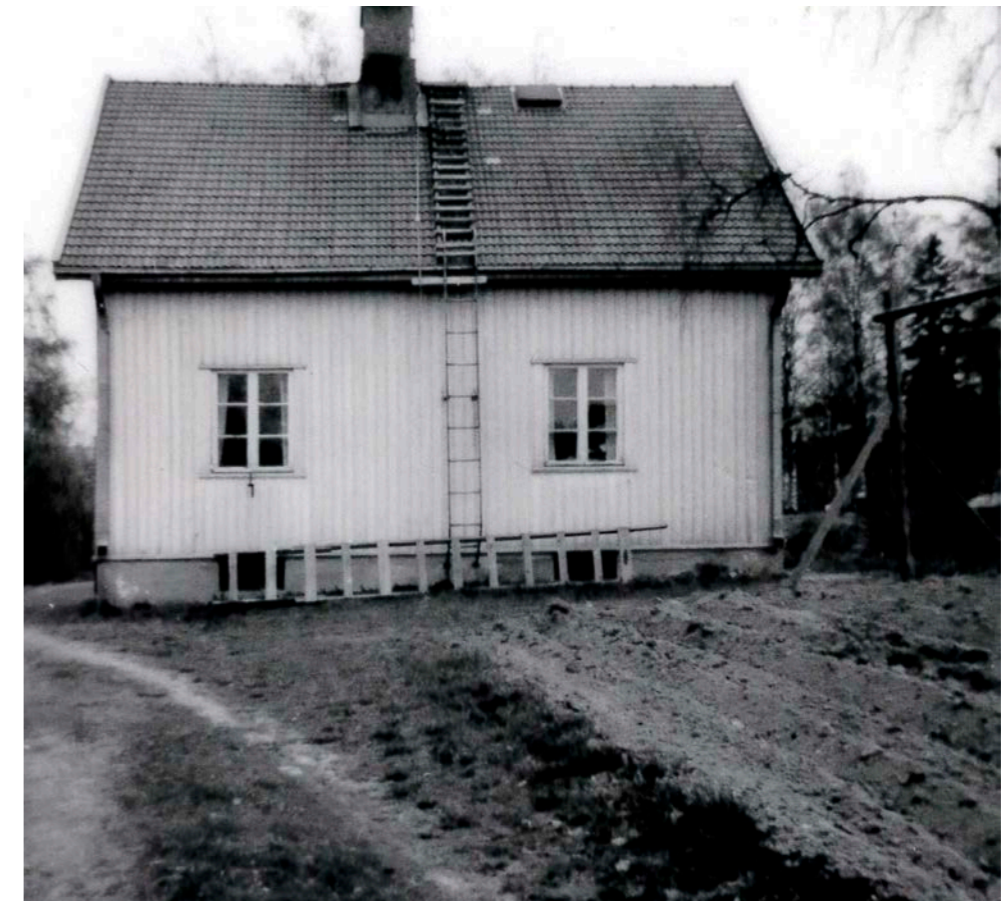
Yllä: Hakalan tilan asuinrakennus ilmeisesti 1940-luvulla, huomaa pärekaton päälle asennettu tiilikatto.
