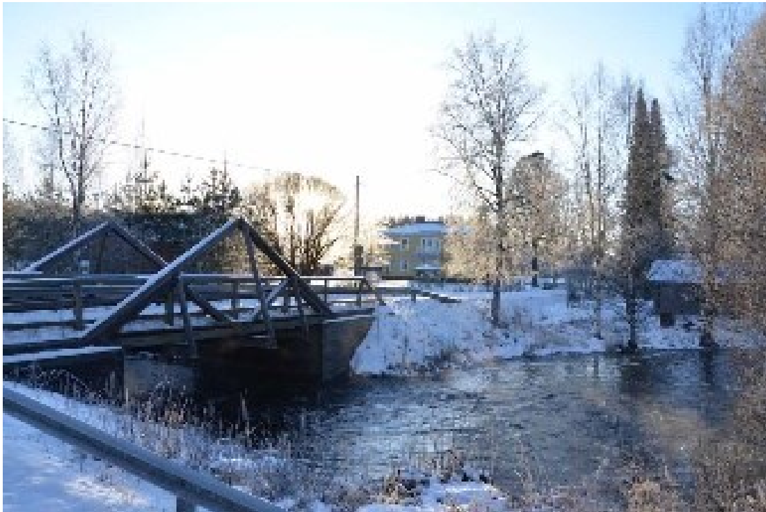
Kuva: Markkulan silta 2020.
