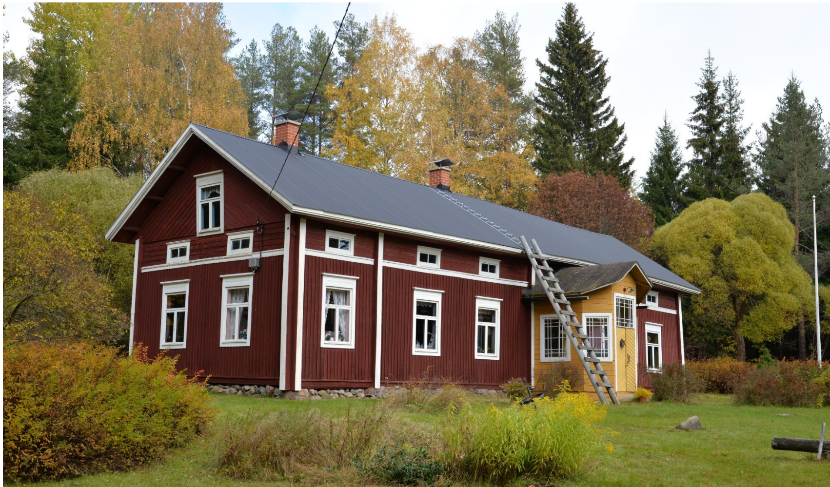
Kuva: Kirvesniemi 2019. Päärakennuksessa hyvin säilyneet punamullatut julkisivut, Kihniössä toistuva sulkapanelointi talon päätykolmiossa sekä keltamullan värillä erottuva mutterikuisti pieniruutuisine ikkunoineen.
