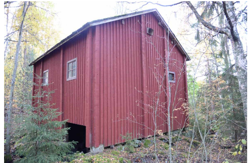
Kuva: Maantiesilta ja myllyrakennus 2019.
