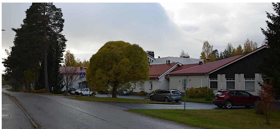
Kunnansairaala ja sen laajennusosat 2019.
