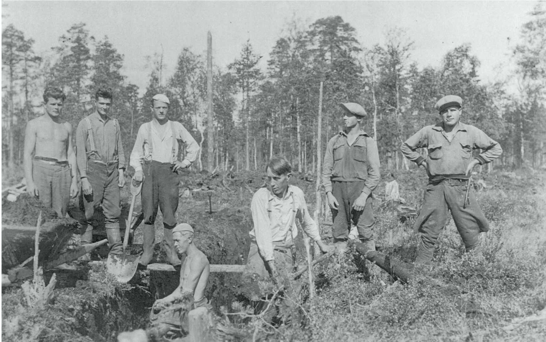
Kihniössä ratapohjan kuivattamista soilla tehtiin ojituksin ja rataa raivattiin käsityönä. Kuva: Rautatien rakentajat. Kaija Yli-Knuuttila.
