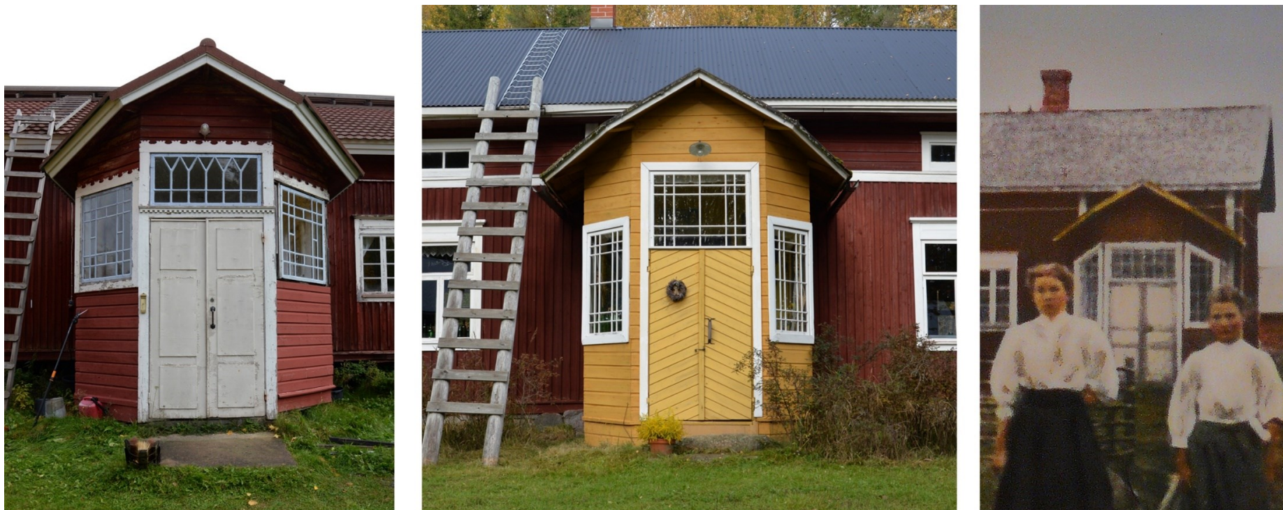
Kuva: Kihniössä yleinen kuusikulmainen kuistityyppi. Uusi-Ristaniemi ja Kirvesniemi 2019, sekä purettu Uusi-Luomalahti eli vanha Penttu.
