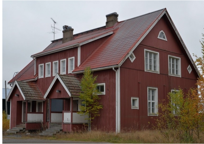
Piirrokset ja kuva: Kankarin koulu 1920-luvun suunnitelmissa ja 2019. Myöhempi julkisivuremontti on karsinut koulun klassismin piirteitä mm. nurkkapilasterit ja vuorilaudat.
