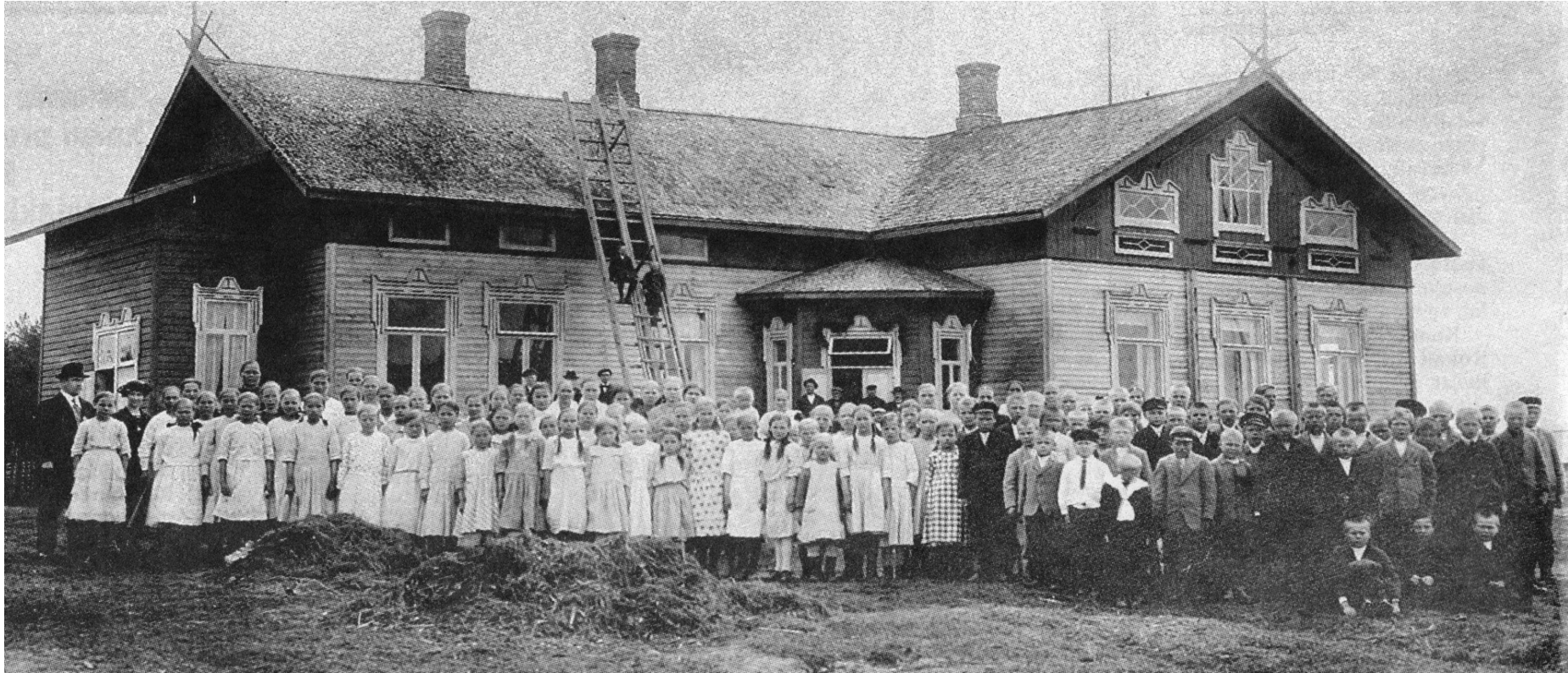
Kuva: Kihniön kansakoululaiset. Rakennus tehtiin Parkanoon 1870-luvulla laadituilla piirustuksilla. Julkisivuun tehtiin koristeelliset ikkunanvuorilaudat ja katon pätyyn spiira-koristeet, jotka edustavat enemmän 1800-lukua kuin 1900-luvun alkua. Hannu Tannisen kokoelma.
