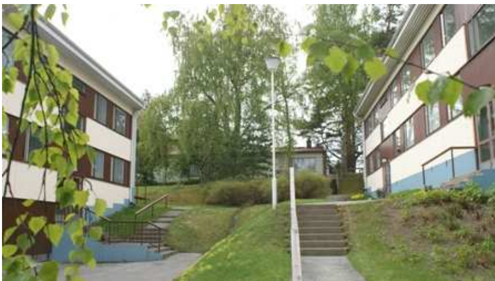
Ruutanantien yläpuolella sijaitseva lamellitalopari. Rakennusliike Aaro Havia Oy:n rakennustuotantoa 1960-luvulta.
