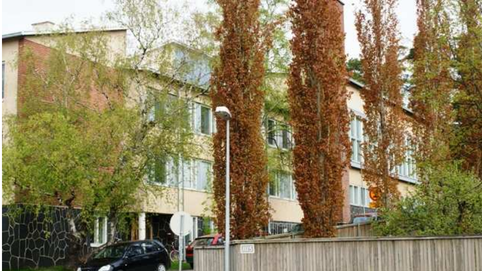
Kirkkoharjun koulurakennus 1960-luvulta.
