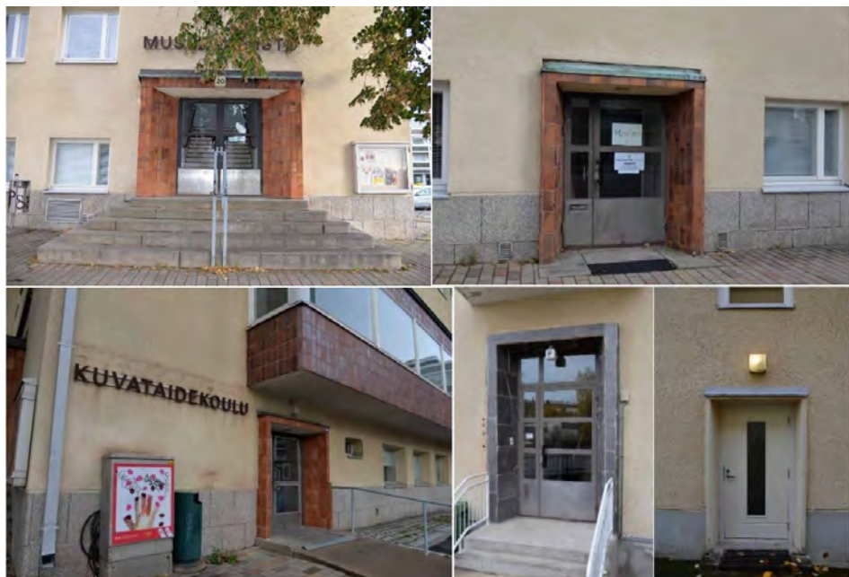
Kuva 22 Julkisivujen alkuperäisiä detaljeja, ylhäällä postin ja poliisin portaalit Valtakadun puolella, alla postin toinen portaali, erkkeri, vesiränni, putkan pikkuikkuna ja sokkelin pesubetonilaatat Keskusaukion puolella, keskellä ylemmän henkilökunnan asuntorapun portaali sisäpihalla, oikealla alemman henkilökunnan asuntorapun portaali.
