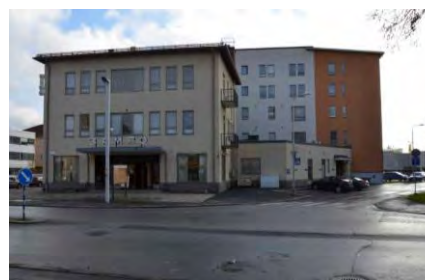
Kuva 12 Työväentalo ja sen uudisosa Valkeakoskenkadun varrella
