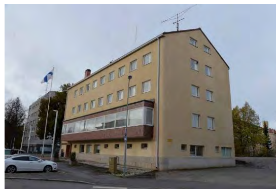
Kuva 21, Pohjoispäätty, autotallit korvattu ikkunoilla.
