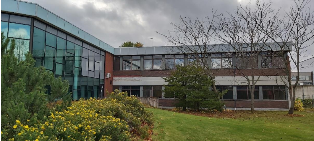
Vuonna 1976 valmistuneen uimahallirakennuksen länsisiipi kuvassa oikealla ja vuonna 2002 valmistunutta laajennusosaa vasemmalla.
