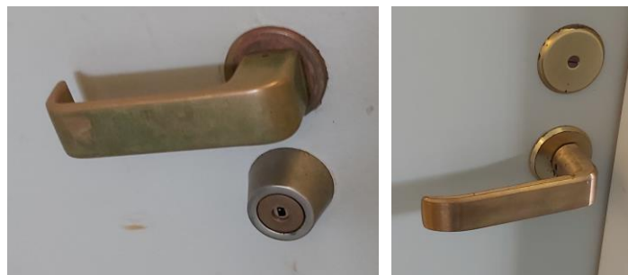
Keskellä tilaussaunaosaston alkuperäinen messinkinen ovenkahva ja lukko. Oikealla viereisen tilan uudistettu ovenkahva, joka jäljittelee alkuperäistä tyyliä.
