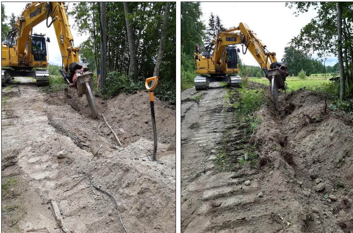
Vasen: Sähköpylväästä itään päin työ tehtiin auraamalla. Kohdassa oli aikaisemmin asennettu kaapeli, ja maat olivat sekoittuneita. Oikea: Työ käynnissä alueen itäreunalla.
