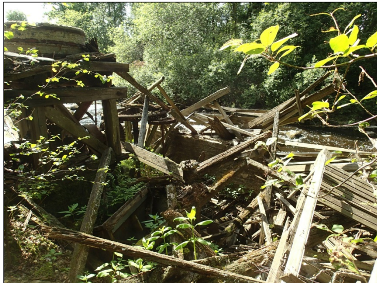
Sahan koneistorakennuksen romahtaneita rakenteita jossa rautaisen koneiston osia ehjänä jäljellä.
