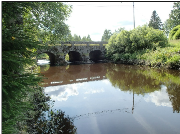
Pääuomaa sillan pohjoispuolella, lounaaseen.
