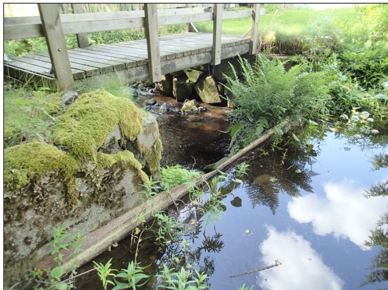
Lautarakenteista pohjapatoa sivu-uomassa myllyn itäpuolella. Sillan betonirakenteita vas.
