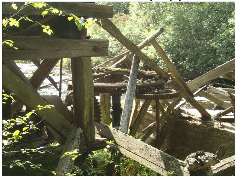
Sahan koneistorakennuksen romahtaneita rakenteita jossa rautaisen koneiston osia ehjänä jäljellä.
