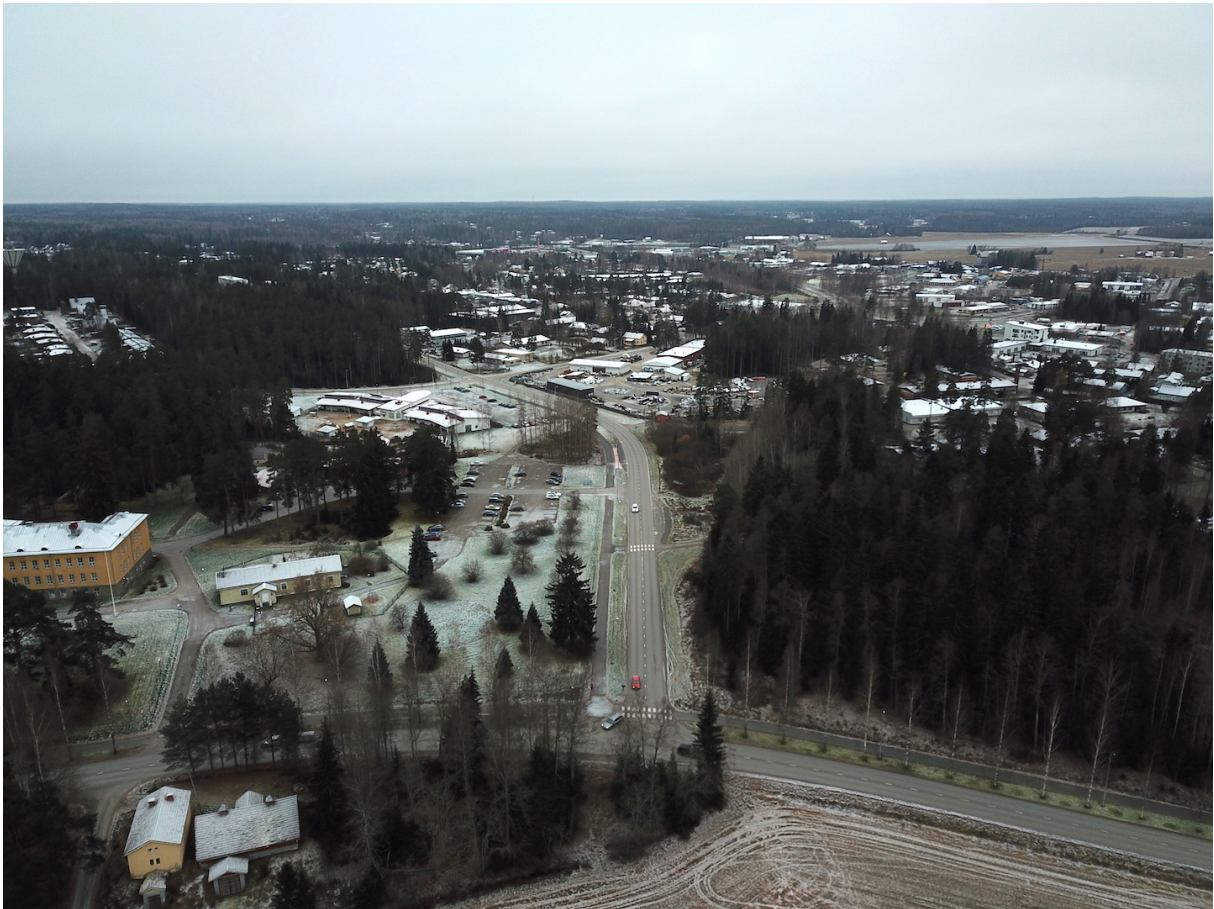
Kuva 2. Viistoilmakuva inventointialueesta. Vasemmalla Sastamalan kaupungintalo ja Ojansuun yksinäistalon 1900-luvun tontti rakennuksineen. Kuvattu etelään. 7.11.2019.
