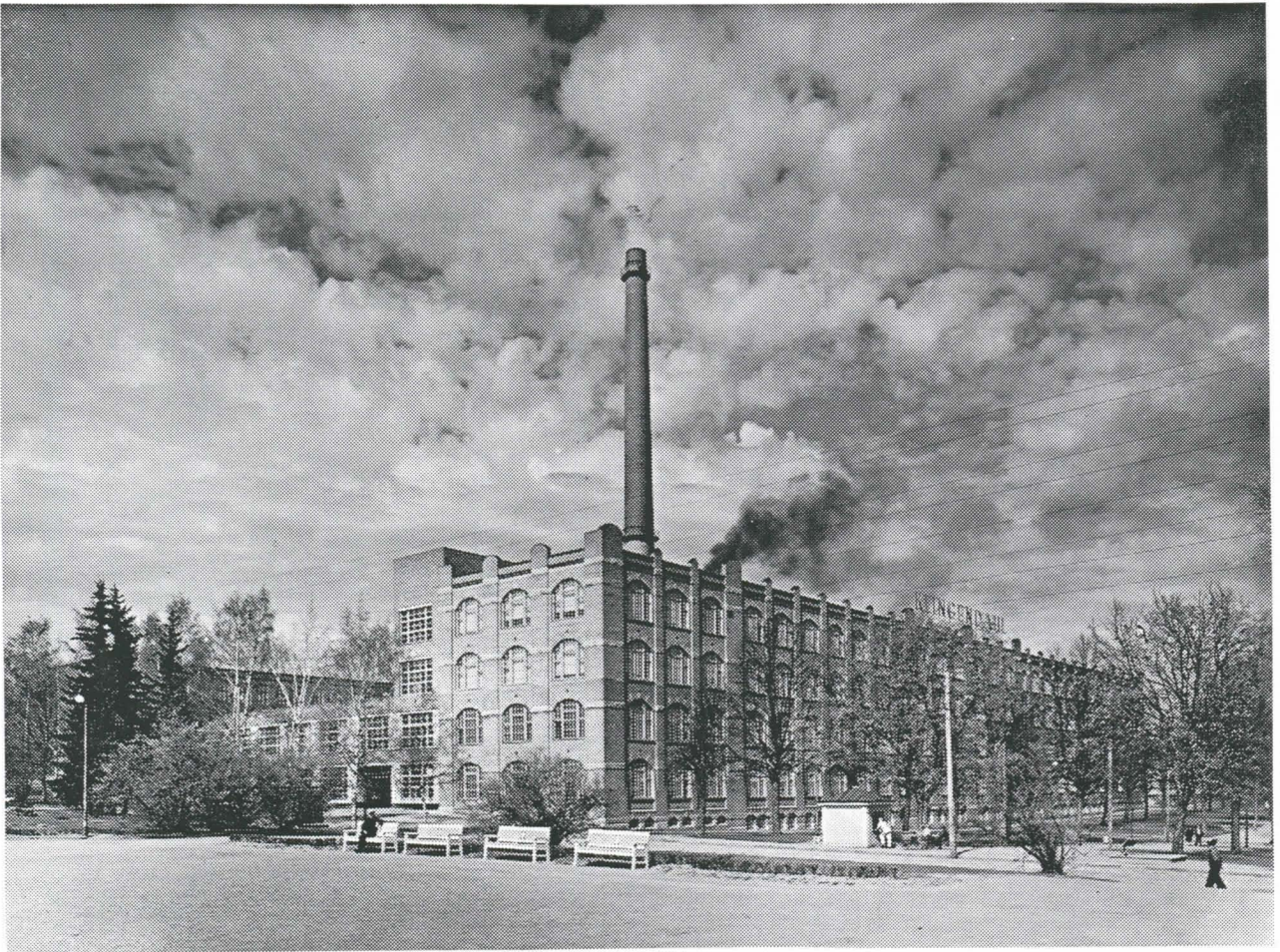
Klingendahlin savupiippu on rakennettu vuonna 1950. Kuva on vuodelta 1952.
