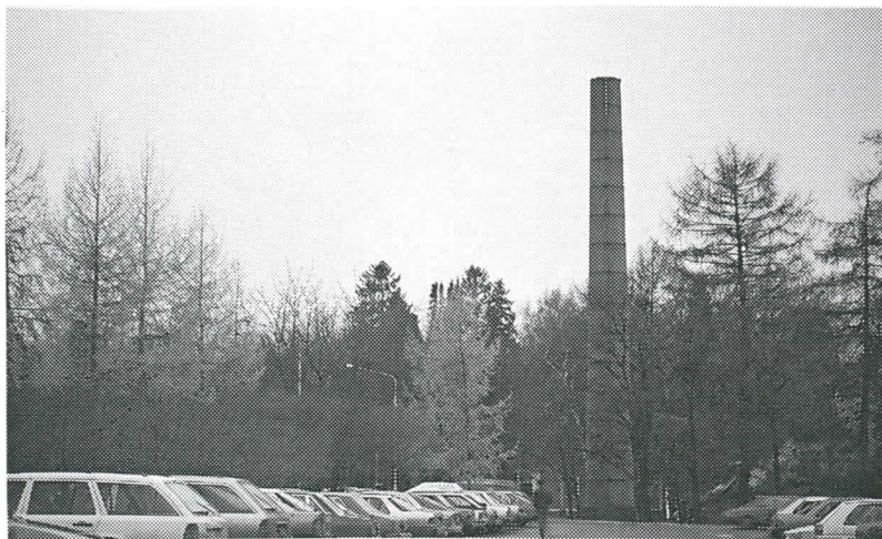
Hatanpään sairaalan piippu.
