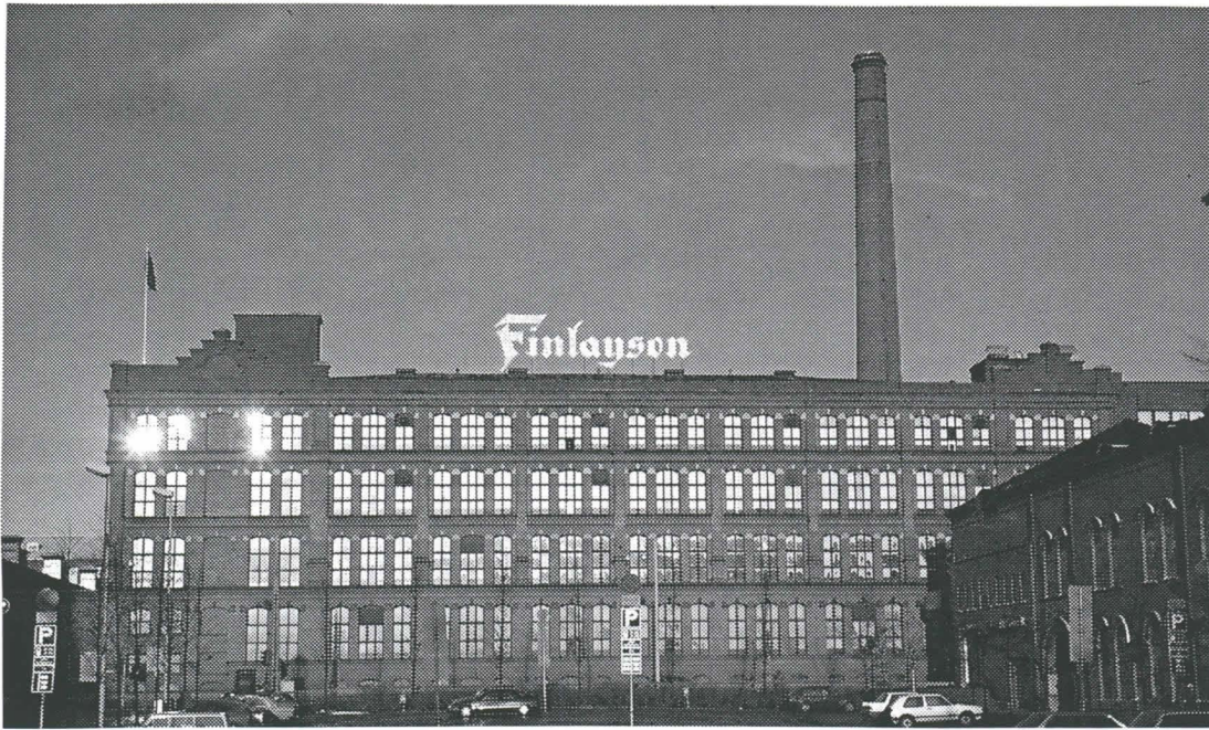
Finlaysonin piippu on rakennettu vuonna 1899. Edelleen käytössä oleva, 64 metriä korkea piippu on hyväkuntoinen.
