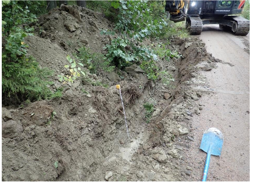
Hekkaperä. Kaapeliojan itä- osa. itään.
