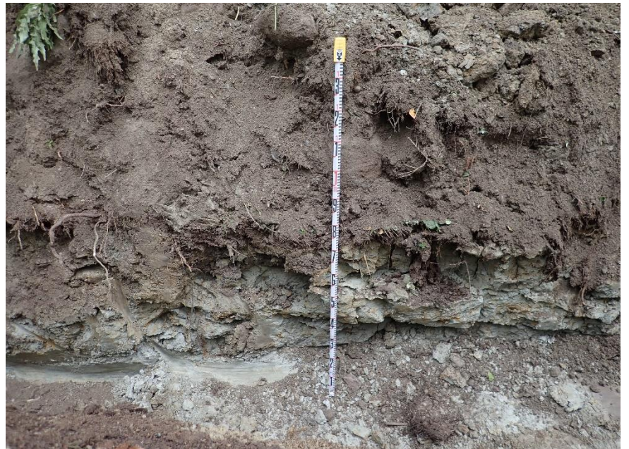
Hekkaperä. Kaapeliojan keskiosaa.
