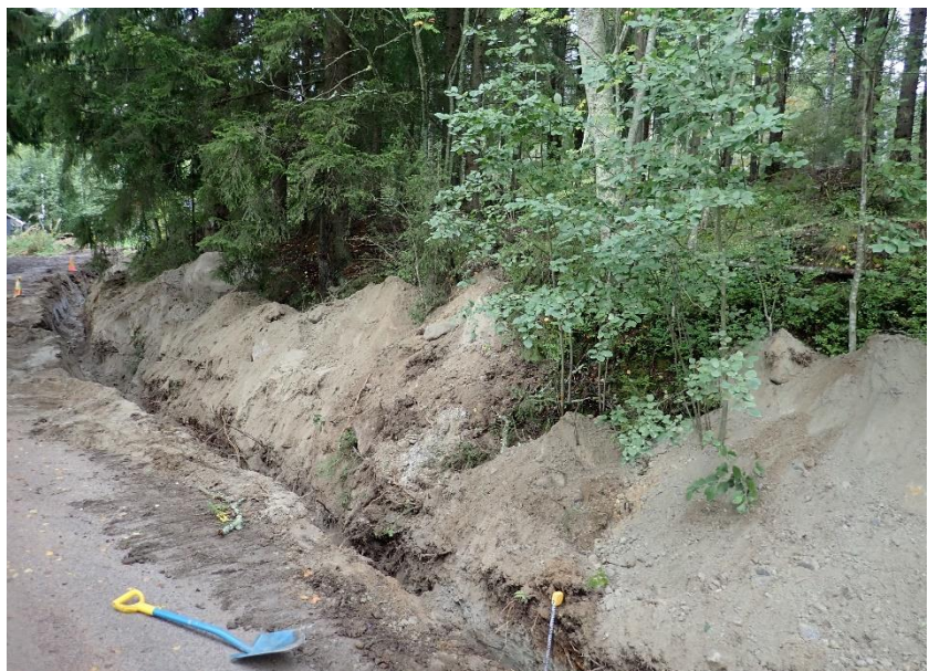
Hekkaperä. Kaapeliojan län- siosa. Länteen.
