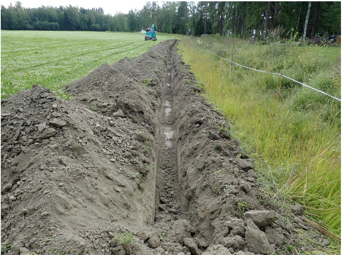
Murronvainion alueelle valvonnan aikana kaivettu kaapelioja. Kaakkoon.
