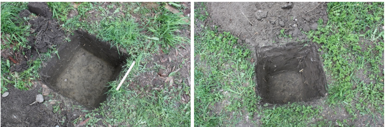
Kuvat 16 ja 17. Vasemmalla koekuoppa 5 pohjaan kaivettuna. Kuvattu etelästä. AKDG6000:10. Oikealla koekuoppa 6 pohjaan kaivettuna. Kuvattu etelästä. AKDG6000:11.
