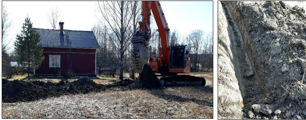
Valvonassa kaivettua maakaapelilinjaa Harjurannan talon pohjoispuolella.
