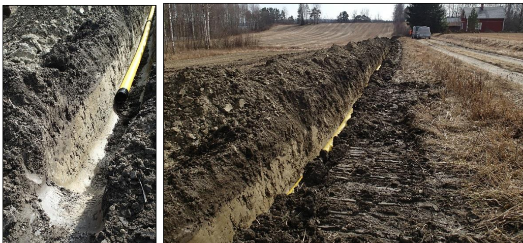
Valvonassa kaivetun maakaapelilinjan eteläistä osaa Likolammintien itäpuolella.
