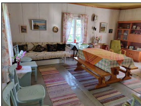
Asuinrakennuksen tupa. Seinät on levytetty 70-80 luvun taitteessa ja lattia on pinnoitettu muovimatolla.
