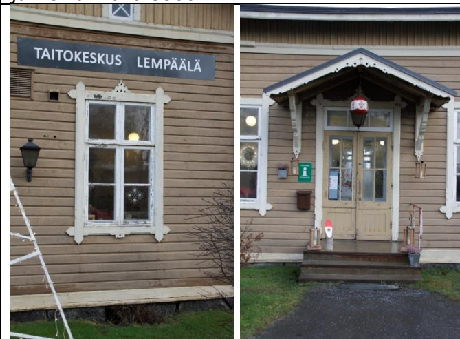
431-1-1 Vanha ikkuna länsijulkisivussa, kivijalka ja pääsisäänkäynnin katos ja vanha ovi. kuva 5258 ja 5256.
