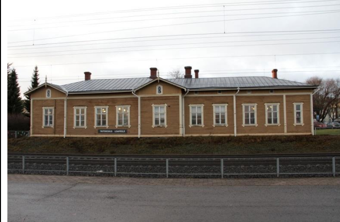
431-1-1 Vanhan aseman idän eli radan puoleinen julkisivu. kuva 5380.
