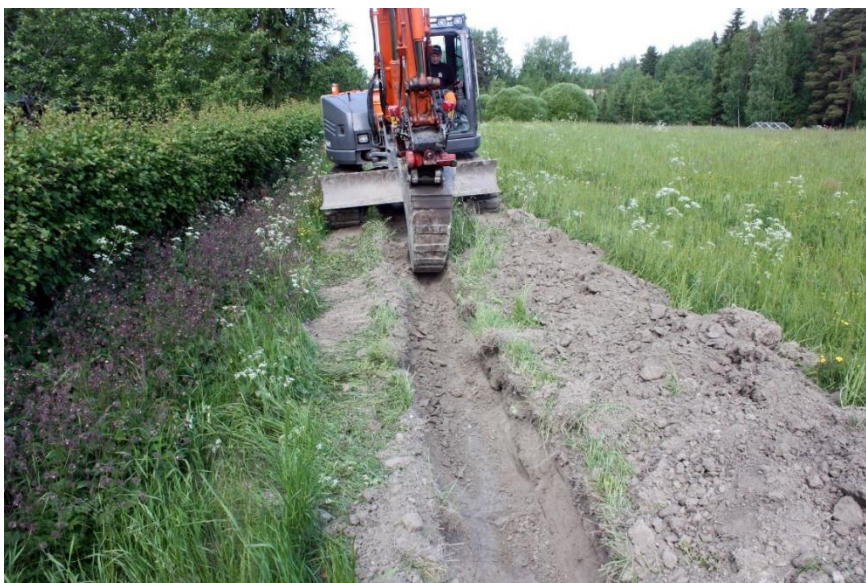
Kuva 4. Putkilinjaa kaivetaan pellon reunalla, kuvattu idästä. AKDG 5628:3
