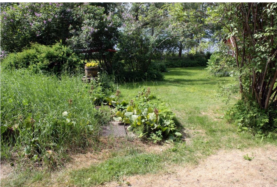
Kuva 7. Pientalotontin vanhat saostuskaivot, joiden kohdalle on suunniteltu asennettavaksi uusi sakosäiliö ja pumppu- kaivo. Kuvattu koillisesta. AKDG 5624:6
