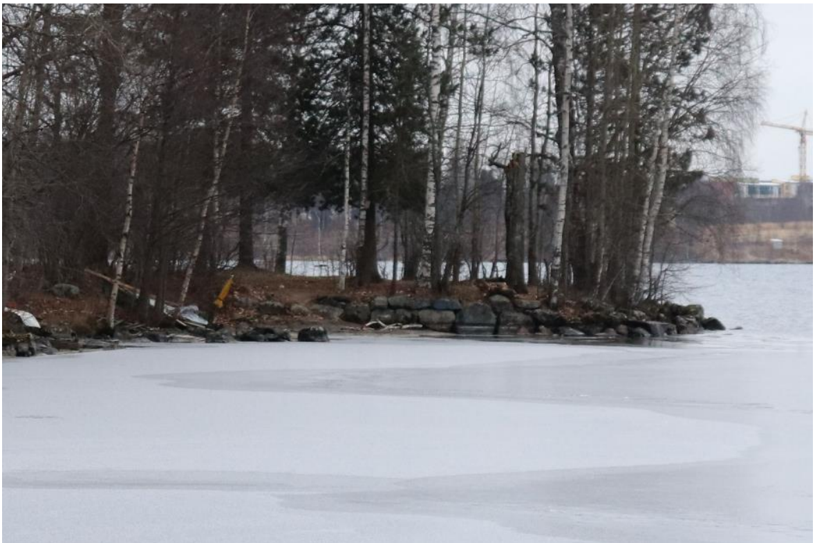
Kuva 22. Pölkylänniemen pohjoisin niemennokka on pengerretty lohkotuilla luonnonkivillä.
