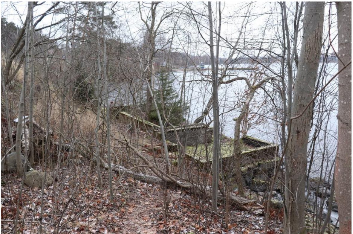
Kuva 20. Saunan jäännös Pölkkylänniemen länsirannalla (kohde 5).
