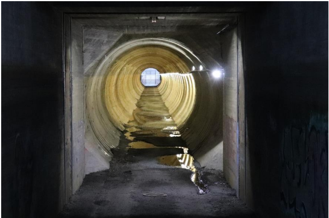
Kuva 32. Pispalanharjun alittava tunneli on muodoltaan pyöreä.
