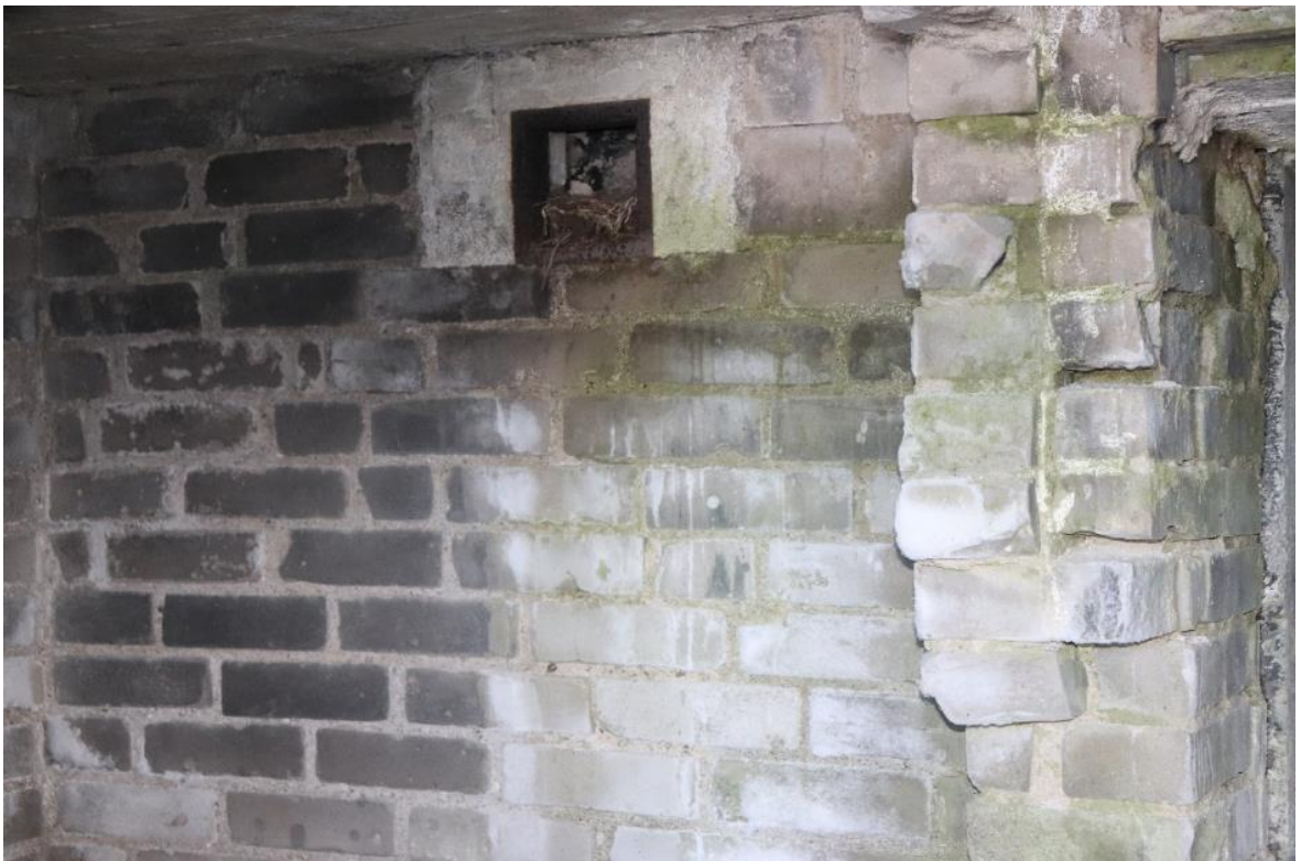
Kuva 14. Kellarin sisätilat on muurattu tiilestä.
