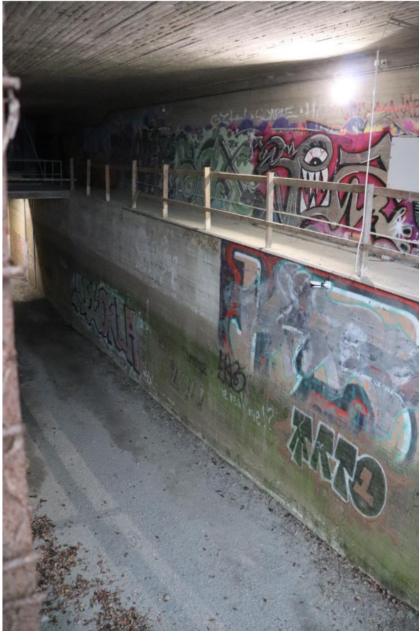
Kuva 28. Uittotunnelin sisäpuolen seinärakenteessa erottuu aikaisempi vesiraja.
