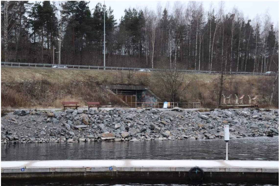
Kuva 29. Uittotunnelin suuaukon yläpuolella kulkee Paasikiventie. Alun perin betonikannen päällä ei ollut täyttöä. Vanhan uittotunnelin suuaukko on ollut hieman nykyistä aukkoa idempänä, eli kuvassa vasemmalla. Paasikiventien pengerrykset peittävät vanhan uittotunnelin suuaukon. Uudemman uittotunnelin suuaukon yhteys veteen on menetetty rannan täytön yhteydessä. Suuaukolta on kuitenkin edelleen näköyhteys Näsijärvelle.
