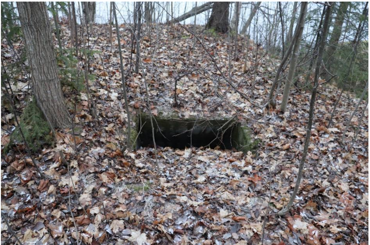
Kuva 12. Töyrään päällä on toinen kulkuaukko kellariin (koko noin 1 m x 1 m).
