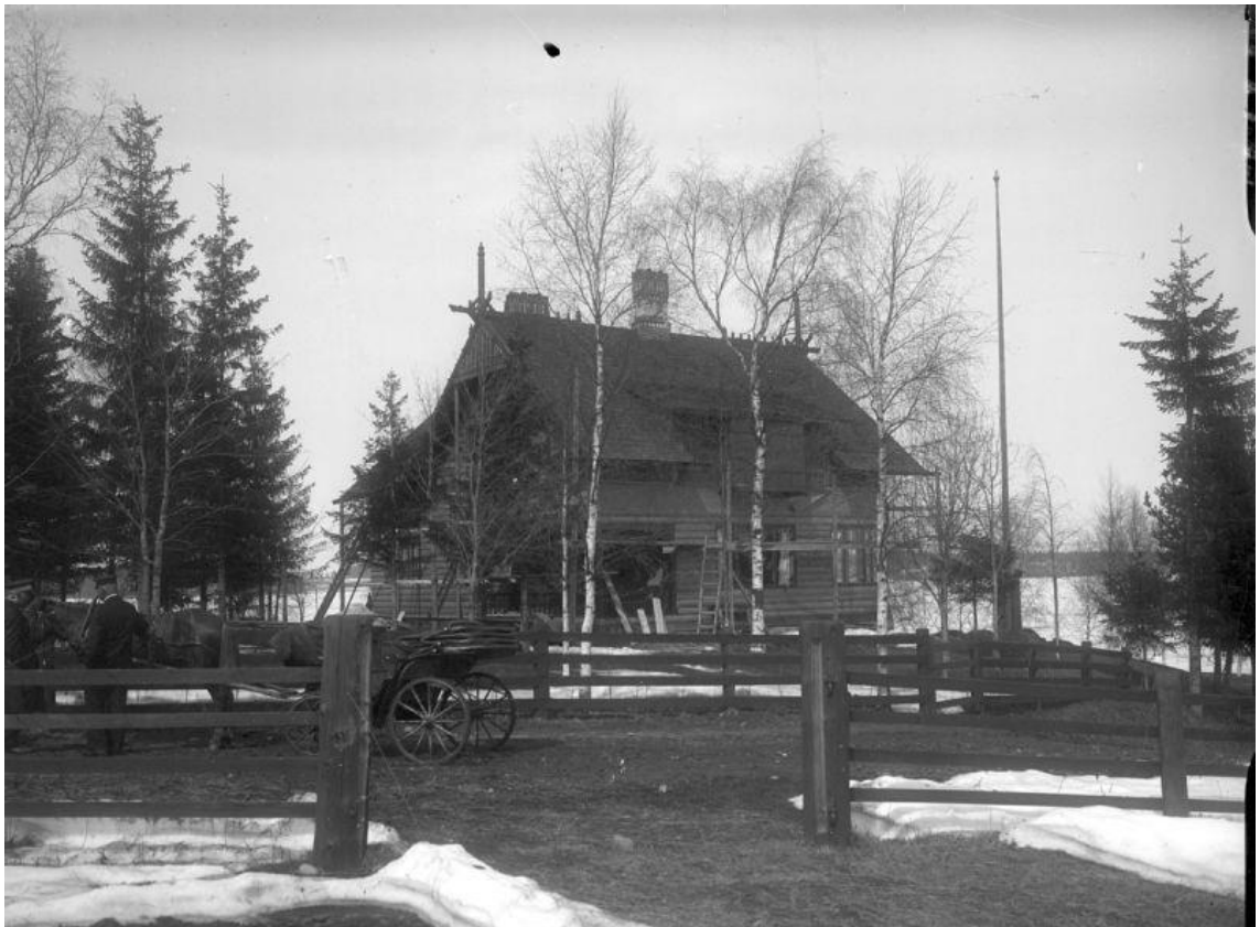
Kuva 4. Pölkylää rakennetaan. Tampereen museot/Siiri HM D/1864.
