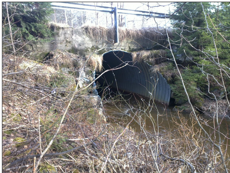
Turkimusojan silta, N 6842873 E 297060 suunta 116
