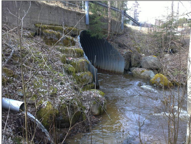
Turkimusojan silta, N 6842842 E 297058, suunta 345
