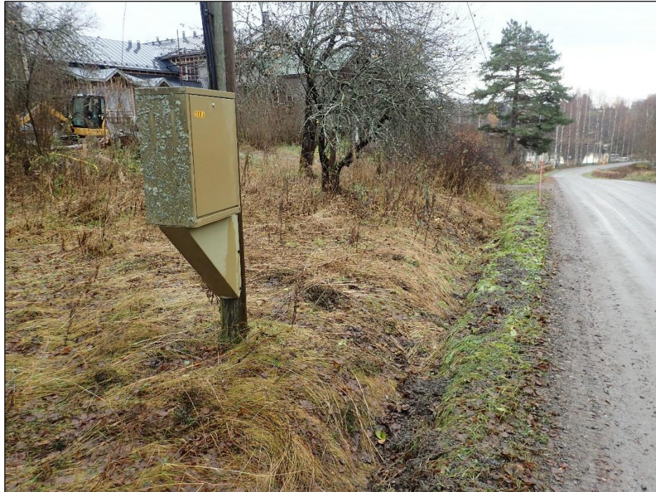
Maakaapelin reittiä ennen kaivutöitä muinaisjäännösalueen luoteisosassa. Kaivutyö tehtiin sähkötolpan ja tien väliin. Eteläkaakkoon.
