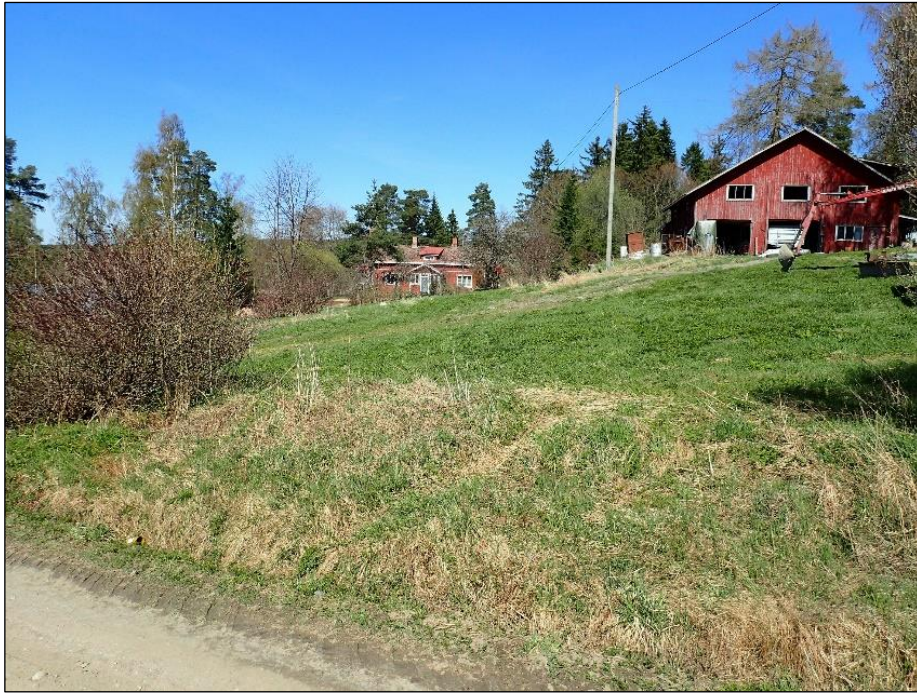
Tulevan maakaapeli kulkee kuvan suuntaisesti kohti taustalla näkyvän talon oikean puoleista kulmaa. Pohjoiseen.
