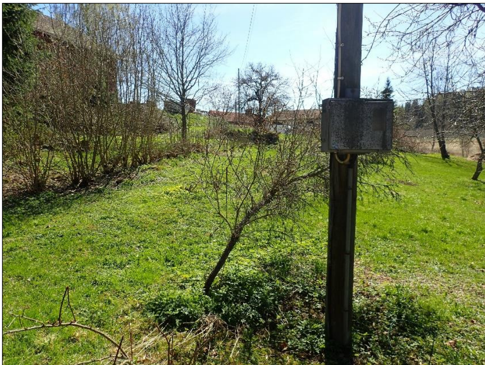
Tuleva maakaapeli kulkee kuvan suuntaisesti, alkaen sähkötolpalta. Etelään.
