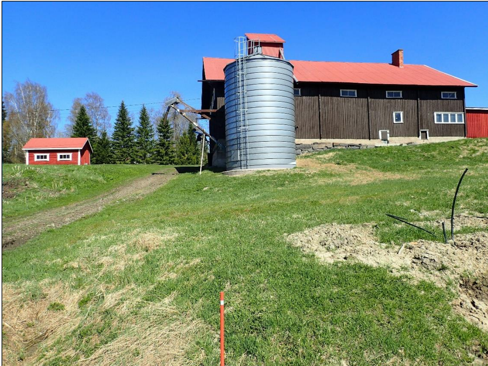
Vanha talontontti sijoittuu talusrakennuksen kohdalle ja sen taakse rinteeseen päälle. Kuvan oikeassa laidassa näkyy jo kaivetut maakaapelit. Kuvattu tieltä kohti koillista.
