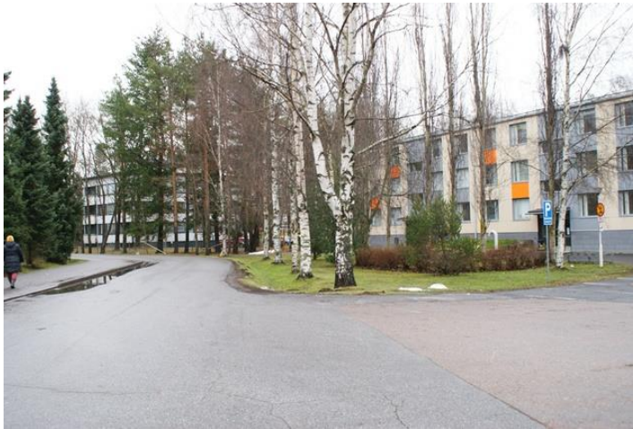
Kuva: Julkisivujen osalta uudistettu 1960-luvun lamellitalo sekä sen perässä Räikäntorni.
