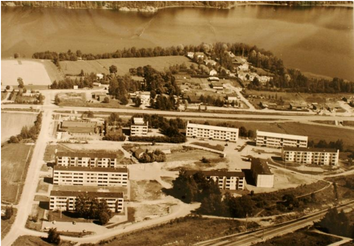
Kuva: Siukolan kerrostaloalueella on ainakin kolmea hieman toisistaan poikkeavaa lamellitalotyyppiä. Taustalla näkyy kerrostaloalueen kanssa samoihin aikoihin rakentunut Pappilanniemen pientaloalue /Kuva Ylöjärven kaupungin valokuvakokoelma
