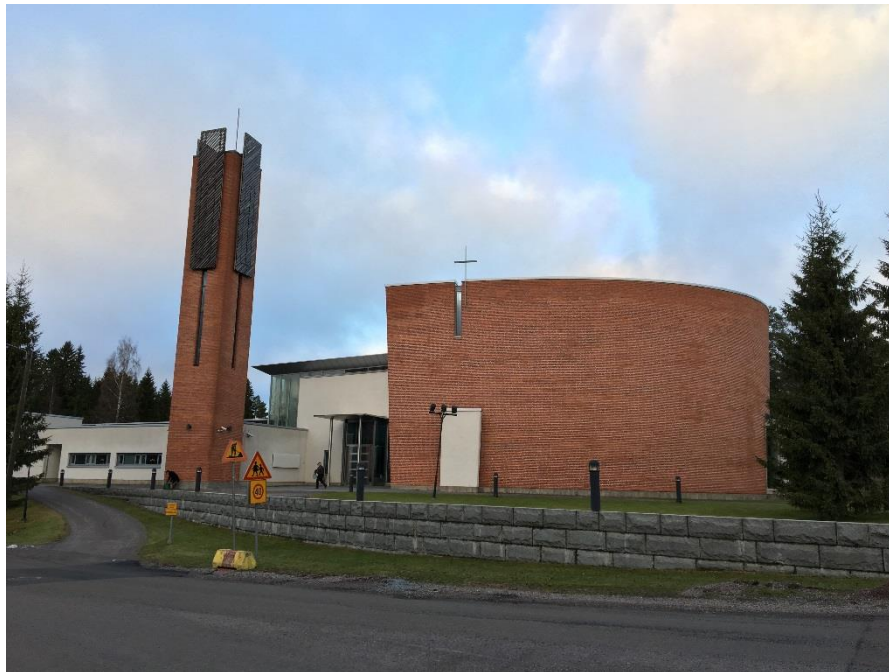
Kuva 14. Olkahisen seurakuntatalo ja Aitolahden kirkko. Kohde on hyvin esillä tarkastelualueelle saavuttaessa vajaan kilometrin päässä tarkastelualueesta.
