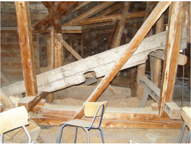
Myös ullakolla on näkyvissä uusiokäytettyjä puuosia.
