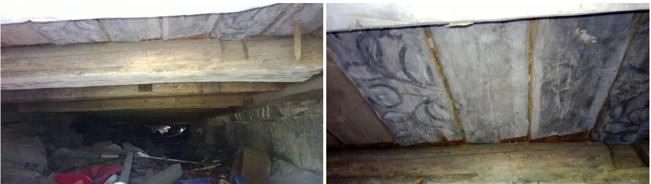
Kasvialheista maalauskoristelu ja lovettuja hirssiä koulun alapohjassa
