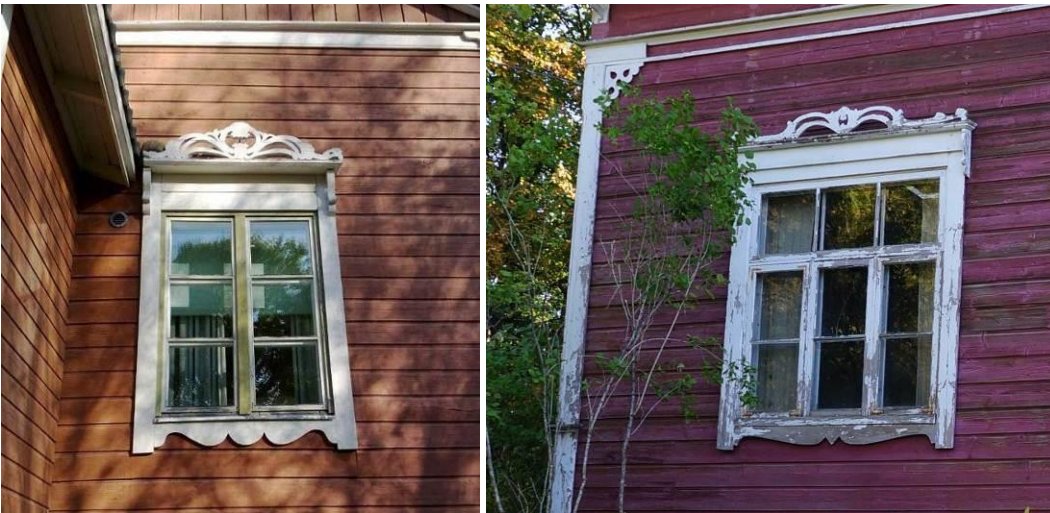
Vasemmalla Uotsolan koulun ikkuna, oikealla Wähätiisalan tilan 1800-luvulla valmistuneen rakennuksen ikkunatyyppejä.
