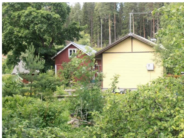
Punainen talousrakennus, etualalla viereisen kiinteistön uudempia rakennuksia.
