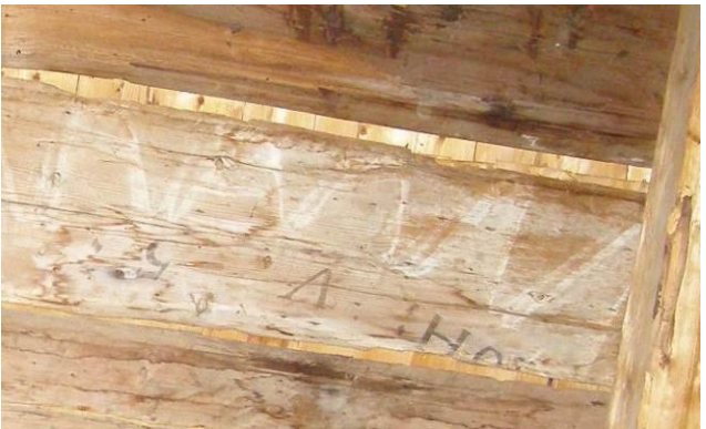
Myös ullakolla on näkyvissä uusiokäytettyjä puuosia.
