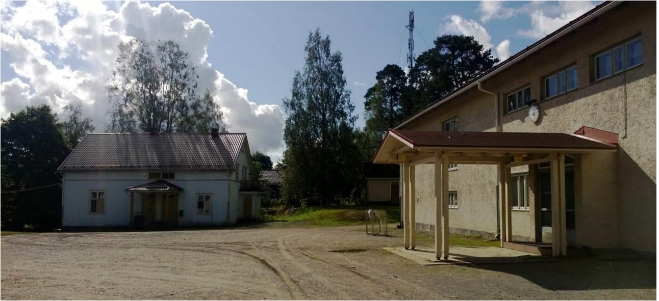
1930-luvun ja 1950-luvun koulurakennukset. Rakennukset on purettu syksyllä 2015.
