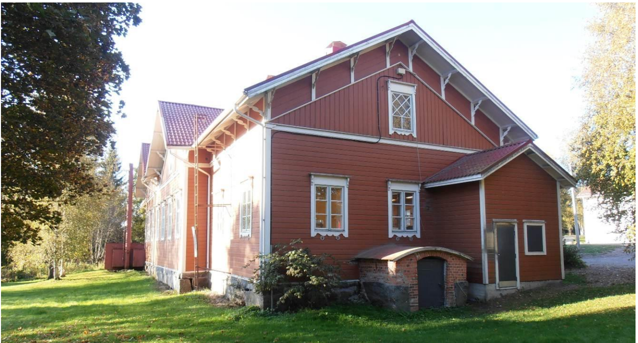
Koulun pohjoispääty ja kellarin sisäänkäynti
