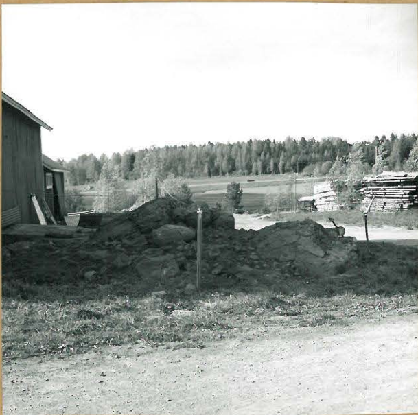
F.48928 KUVA 3. SAMAN KAIVAMUSVAIHE KUIN EDELLEISISSÄ KUVASSA. KU- VATTU ETELÄKAAKOSTA.
