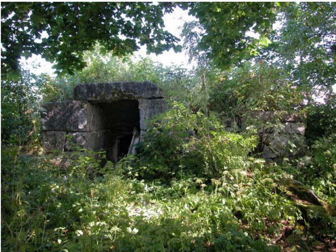
Kuva 2. Kellari 1:n suuaukko (DG132:27.JPG).
