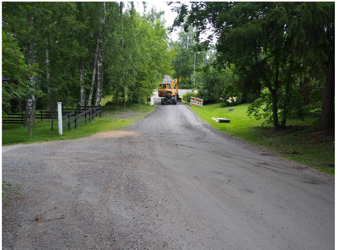
Kuva 2. Pohjoisempi kaivukohta kuvattuna etelästä.
