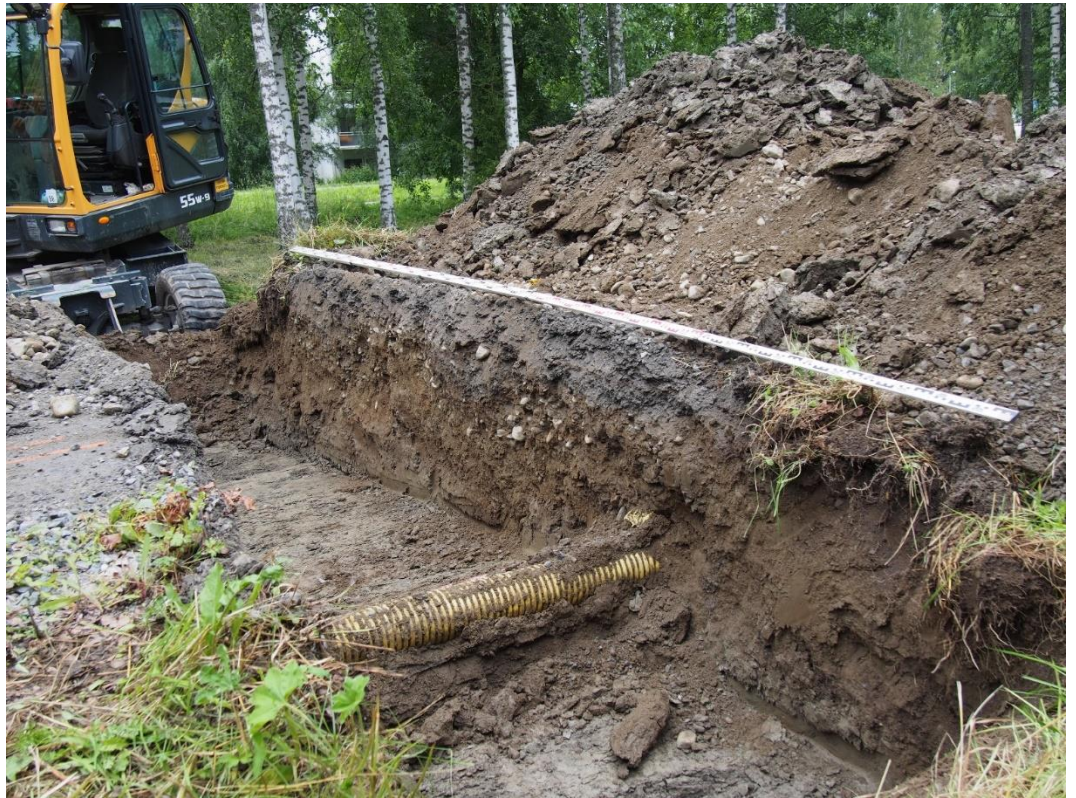
Kuva 4. Eteläisempää kaivantoa kaivetaan. Tien alle on asennettu sähkö- ja puhelinkaapeli pohjasaven ja tienpohjan väliseen kerrokseen.
