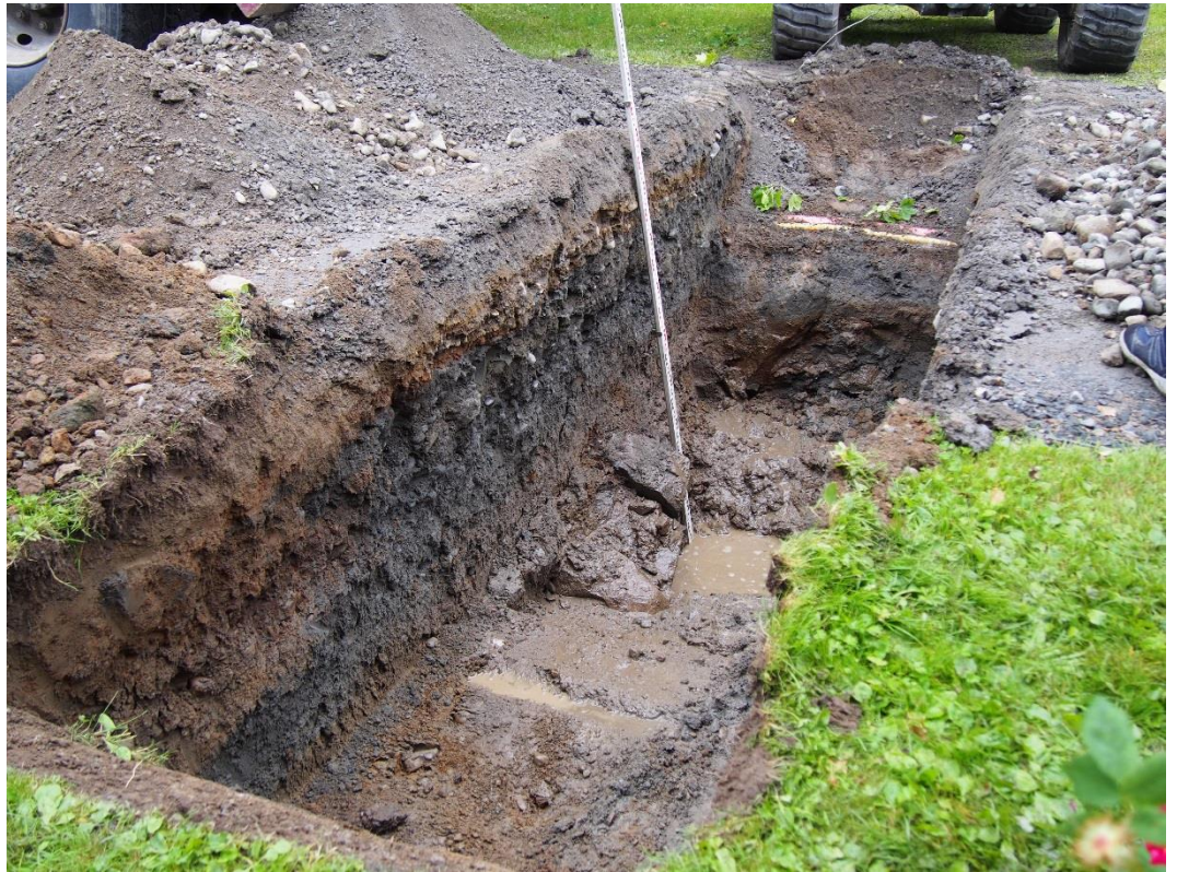
Kuva 3. Pohjoisempi kaivanto kaivettuna pohjaan. Kaivannossa havaittiin paksu täyttösorakerros. Kuopan pohjalle nousi vesi.
