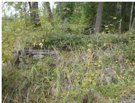
Rakennuksen alahirsiä, kuvattu idästä.
