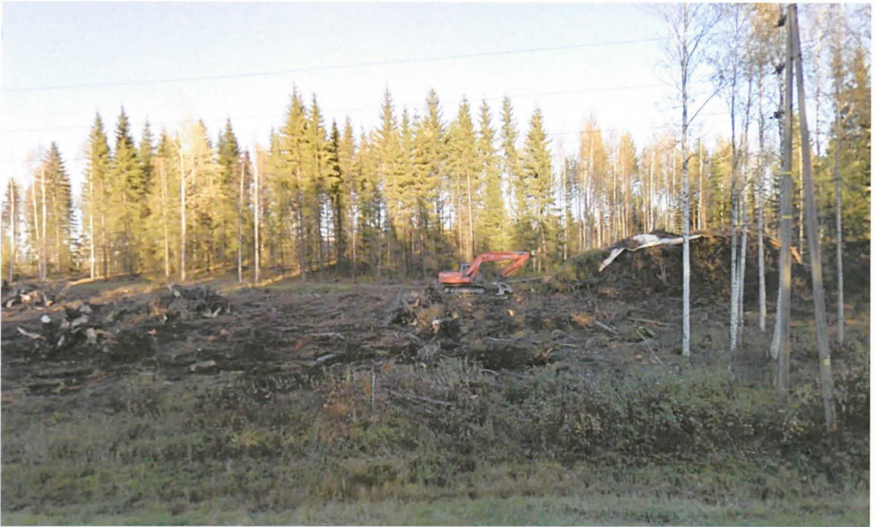
Vanha tielinja kulkee metsätienä taustalla, hakatun metsän reunan ja kaivinkoneen välillä. Kuvattu n. 150 m vt 3:n ja Häijäntien risteyksen luoteispuolelta koilliseen.
