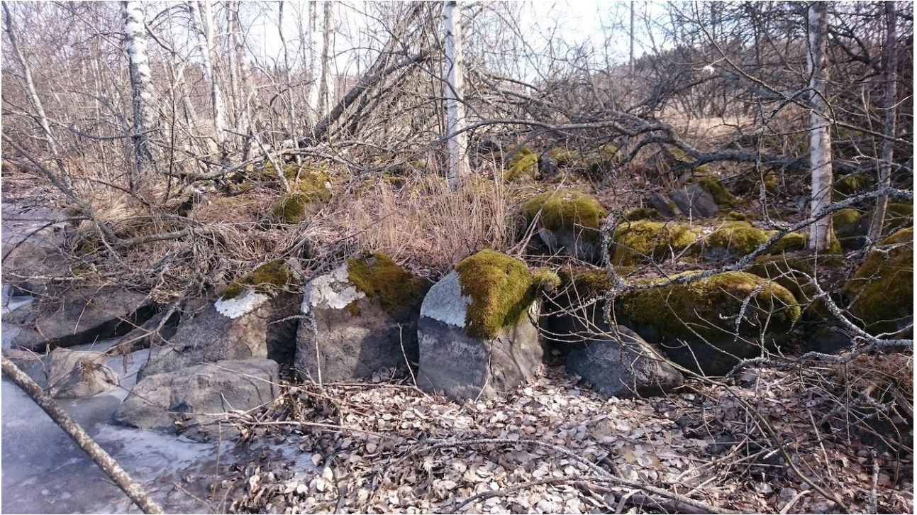
Kuva 11. Laiturin länsipuoli. Kuvaussuunta itään.
