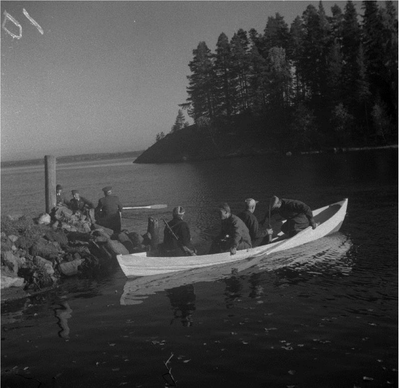
Kuva 17. Hirsiarkkurakenteinen laituri Päirenniemessä Jaakkaanlahden kapeikossa. Taustalla Kurjenkallio. Kuvalähde: Vapriikin kuvakokoelmat, TKM 452:32331:10.
