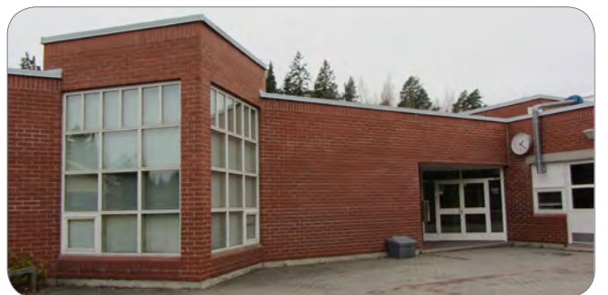
Hakkarin koulu, 2. rakennusvaihe (27.9.2016).
