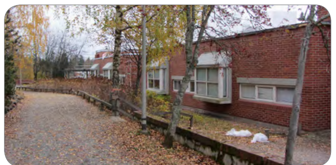
Hakkarin koulu, 1. rakennusvaihe (27.9.2016).
