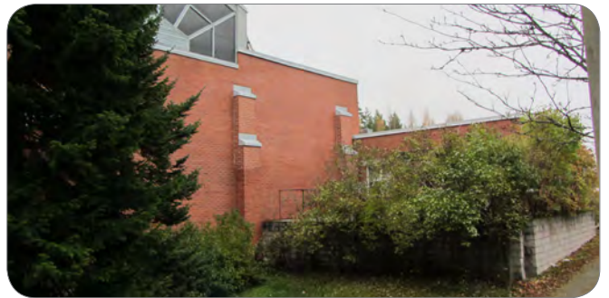
Ummistettu yläikkuna, suojatut julkisivujen pilarit ja laajennettu terassi (16.10.2016).
