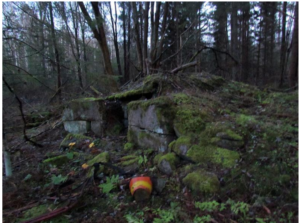
Kuva 39. Pättiniemessä Pättiniementien eteläpuolella sijaitseva lohkokivistä rakennettu kivikellari sekä muita raunioita.
