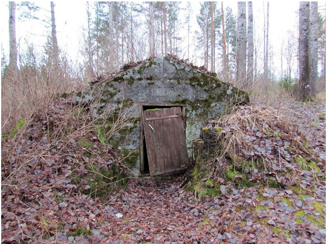
Kuva 31. Kellari, jonka päätyyn on hakattuna päiväys 30.8.1918. Kyseessä on rinteseen holvattu kellari.
