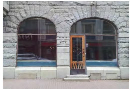
Kuva 53 ja 54. Liiketilöjen ja kellarin ikkunoita suoja-aitauksineen. Kuvan oikeassa reunassa näkyy porrashuoneen sisäänkäynti. Kuva 1900-luvun alusta. VVA. Oikealla graniittisokkelissa näkyy merkkejä ovi- ja ikkuna-aukotuksissa tapahtuneista muutoksista, 2016. AA.
