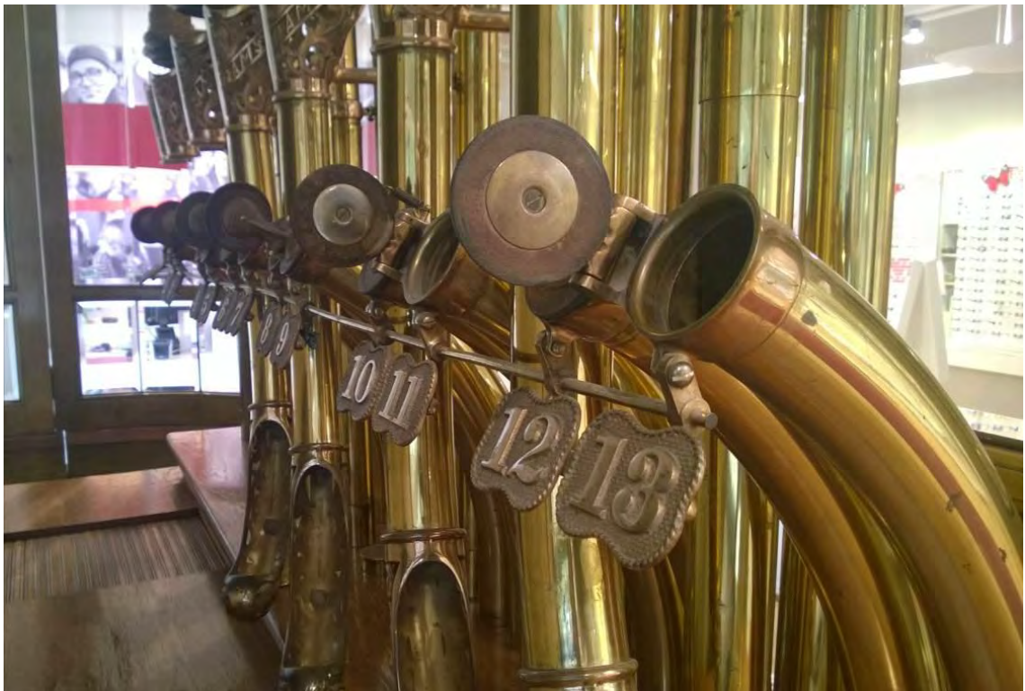
Kuvat 38-40. Putkipostijärjestelmä kulmaliiketilassa 1906 ja 2016. Tila on ollut yhteydessä Kuninkaankadun puoleiseen laajennusosaan. Katossa näkyvä palkki on vanhan osan ja laajennusosan rajakohdassa. Kuva kirjasta Tampereen Jugend ja AA.
