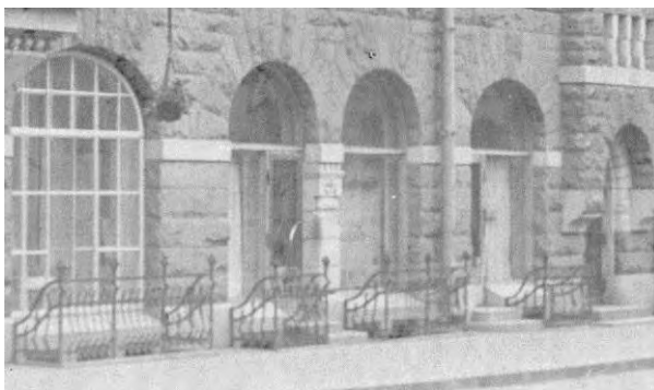
Kuva 53 ja 54. Liiketilöjen ja kellarin ikkunoita suoja-aitauksineen. Kuvan oikeassa reunassa näkyy porrashuoneen sisäänkäynti. Kuva 1900-luvun alusta. VVA. Oikealla graniittisokkelissa näkyy merkkejä ovi- ja ikkuna-aukotuksissa tapahtuneista muutoksista, 2016. AA.
