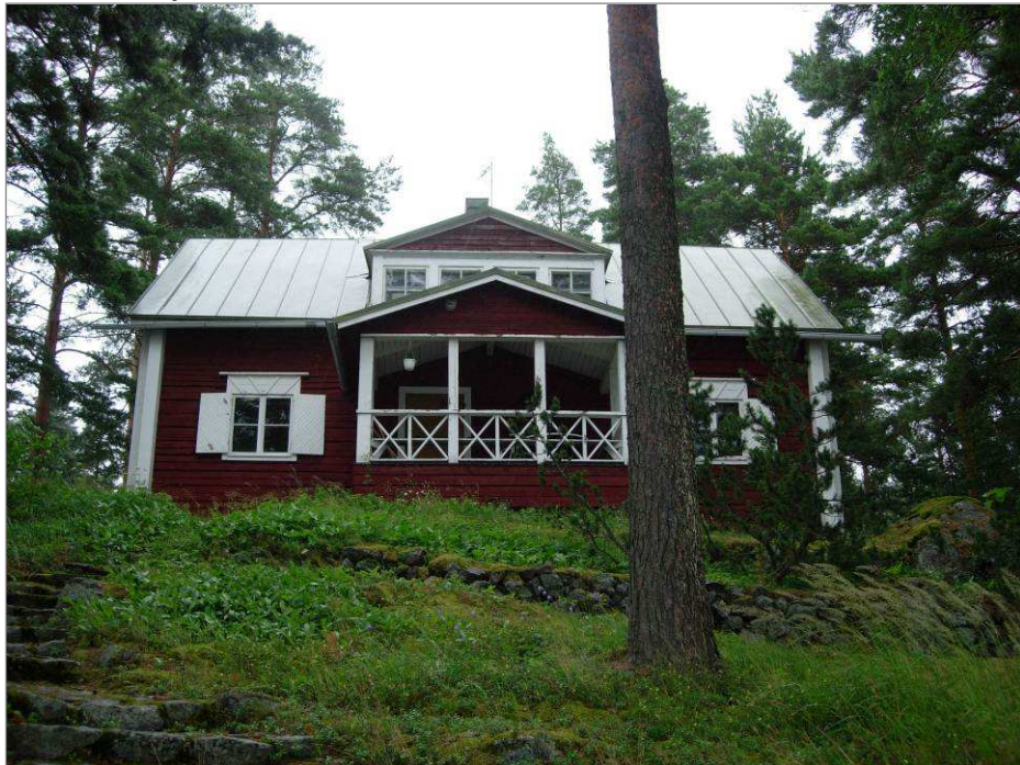
Kuva 15. Rakennuksen läntinen, järvenpuoleinen julkisivu. Kuvattu lounaasta.
