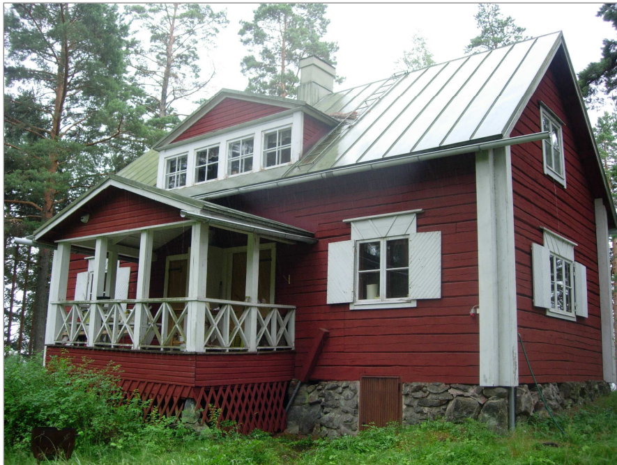
Kuva 19. Itäinen eli metsänpuoleinen julkisivu. Kuvattu koillisesta.
