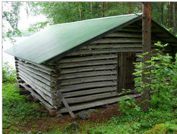
Kuva 44. Venesuoja kuvattuna kaakosta.
