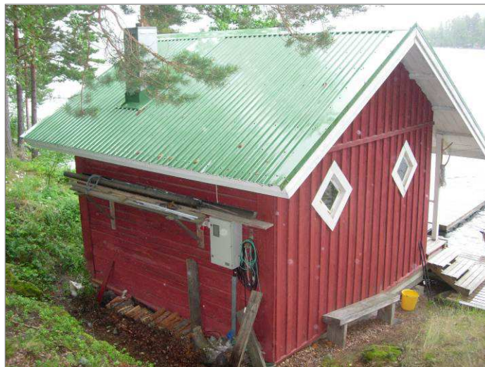
Kuva 32. Sauna kuvattuna pohjoisesta.
