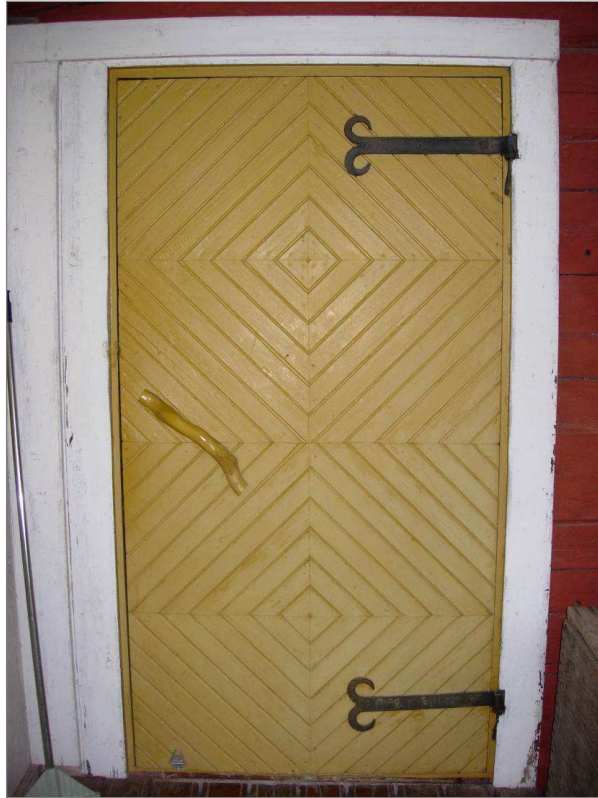
Kuva 21. Yksityiskohtakuva itäisivun toisesta helmiponttipaneloidusta ulko-ovesta. Rakennuksen kaikki ulko-ovet (3 kpl) olivat samanlaisia.
