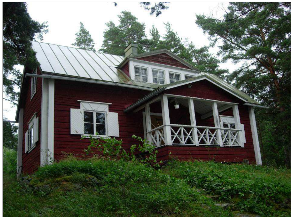
Kuva 16. Rakennuksen läntinen, järvenpuoleinen julkisivu. Kuvattu länsilounaasta.
