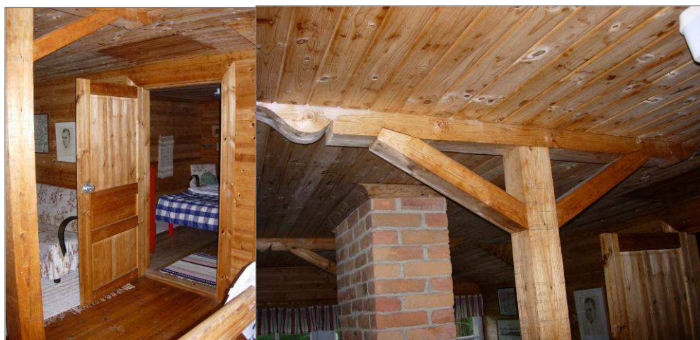
Kuvat 28-29. Yläkerran alkuperäistä, puusta tehtyä verhoilua. Myös yläkerran ovet ovat alkuperäiset. Kattohirsien päät oli muotoiltu kauniisti.
