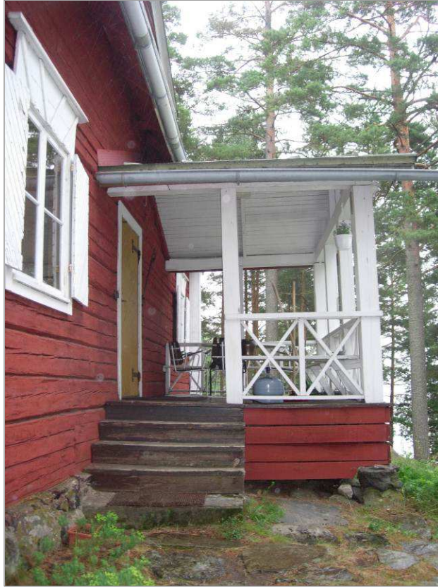
Kuva 17. Järvenpuoleinen eli läntinen avokuisti. Kuvattu luoteesta.
