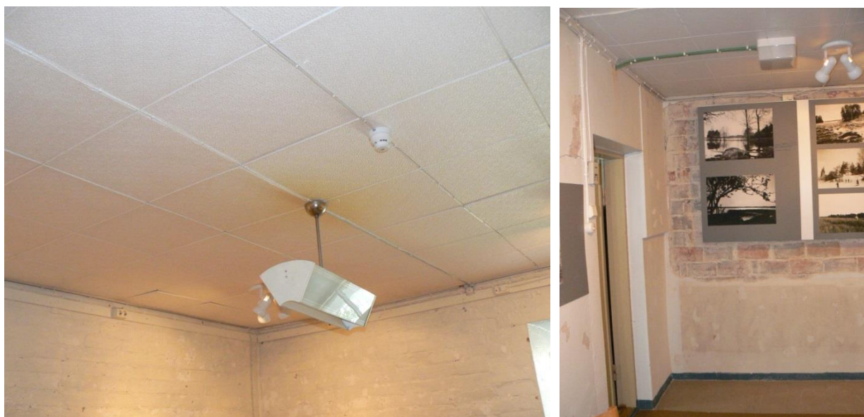
Noin 2 metriä paksuun kiviseinään on entiseen lantaruuman aukkoon tehty eteistila museonhoitajan asuntoon. Näyttelytilojen rapattupintaisia seiniä on rikottu nähtävästi sisustuksellisista syistä. Katoissa on puukuitulevytystä.
