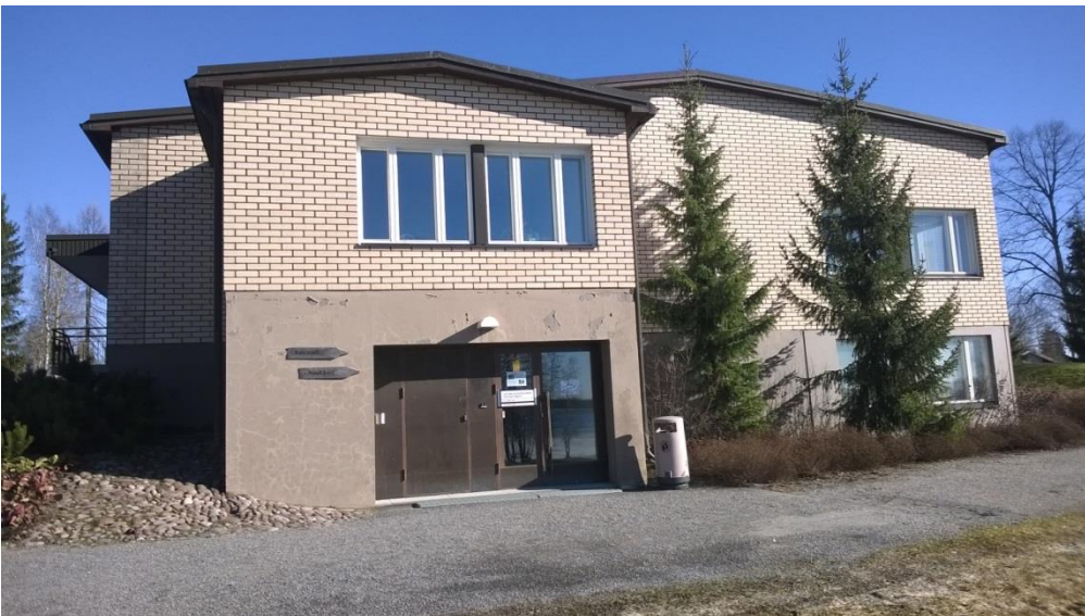
Rakennuksen länsipäädystä kuljetaan nuoris- ja kerhotiloihin, diakoniatoimistoon ja portaita ylös "Rantasaliin". Alkuaan ulokemainen eteis- ja porrashuoneosa oli yksikerroksinen: pääkerroksen tiloihin kuljettiin portaita pitkin nuorisotilojen sisäänkäynnin päällä olleelta terassilta. Kahviotilojen laajennus peittää tästä kulmasta taakseen kirkkosaliin kokonaan, jonka vuoksi rakennuksen alkuperäistä olemusta on vaikea hahmottaa Jaatsinkadun pysäköintialueen suunnasta.
