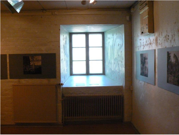
Lämmityspatterit ovat osin 1950-luvulta. Sähköt on pääosin uusittu. Rakennukseen on asennettu v. 1987 automaattiset palovaroittimet.
