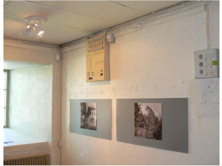
Lämmityspatterit ovat osin 1950-luvulta. Sähköt on pääosin uusittu. Rakennukseen on asennettu v. 1987 automaattiset palovaroittimet.
