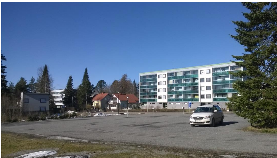
Jaatsinkadun lamellikerrostalo (1973) ja funkspientalo (1930).
