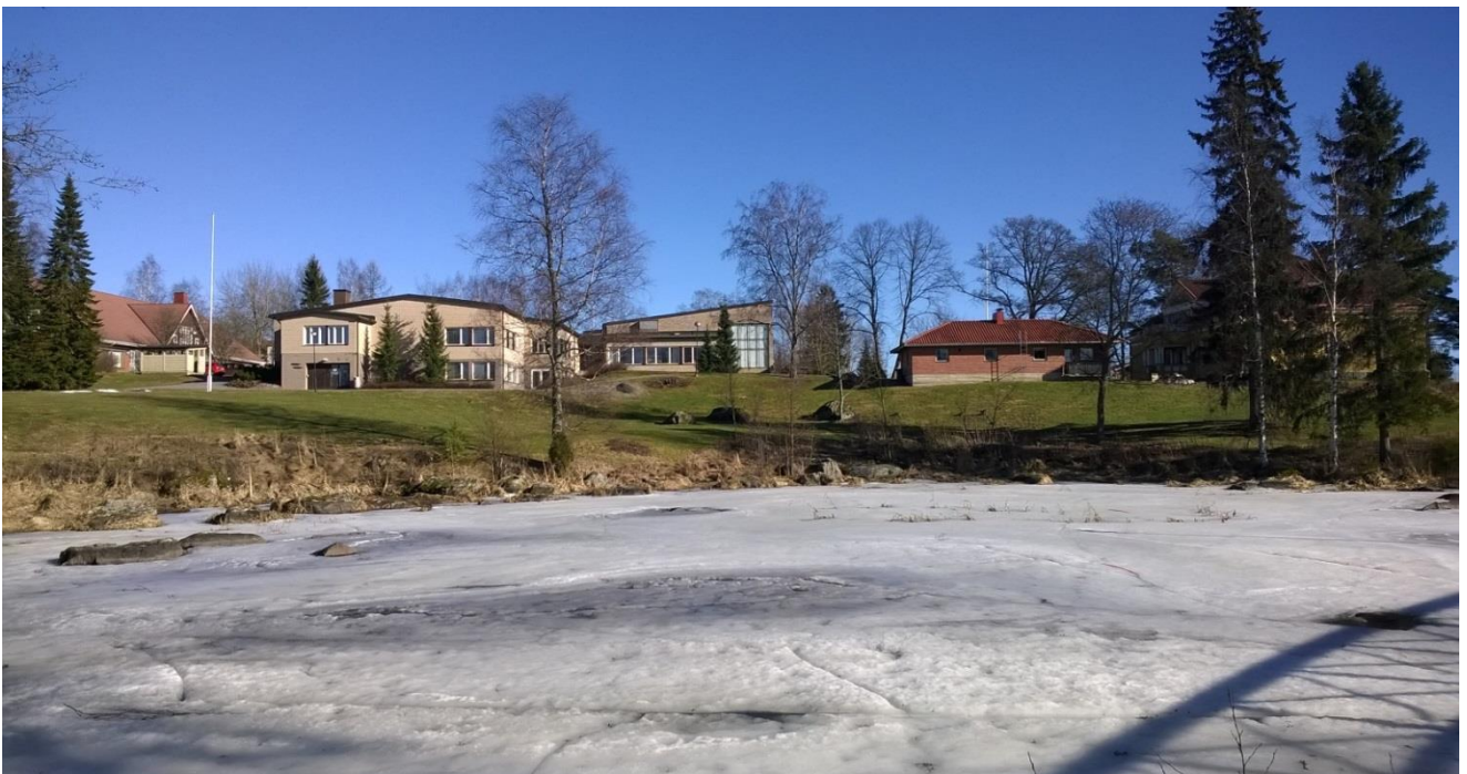
Seurakuntatalo ja sitä ympäröivät rakennukset näkyvät hyvin Pappilanpuiston kävelytieltä. Laajennuksen ja kattomuutoksen vuoksi seurakuntatalon olemus on merkittävästi muuttunut. Salisiipi on hyvin säilyttänyt alkuperäisen ilmeensä.
