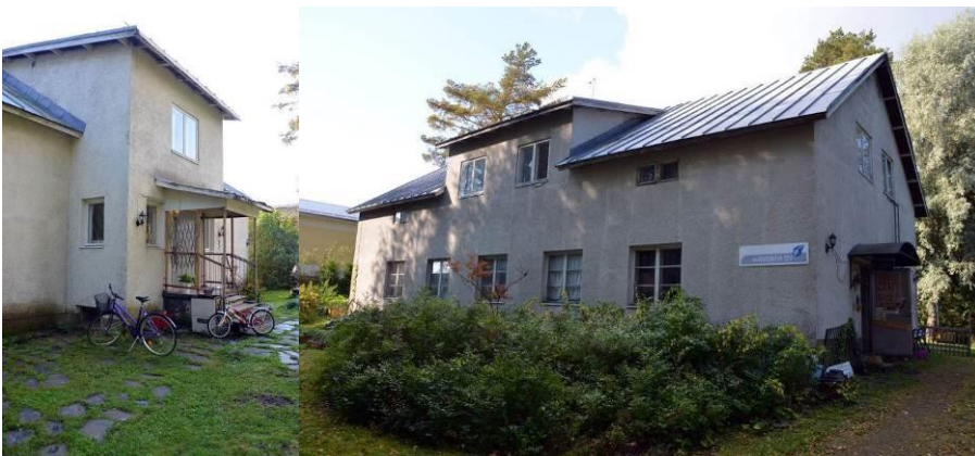
Kuvat: Asuin- ja pajarakennus länsi- ja itäjulkisivua
