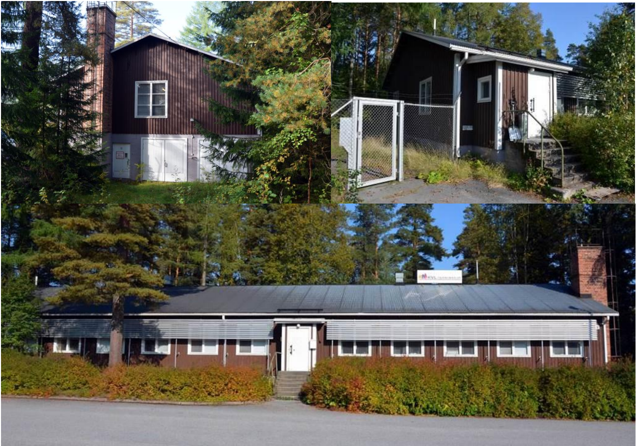
Kuvat: Rakennuksen itäpäätyä, länsipäädyn umpikuisti ja eteläpuoleista julkisivua.
