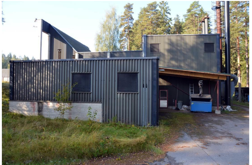
Lämpökeskus itäpuolelta, etualalla tekninen tila.
