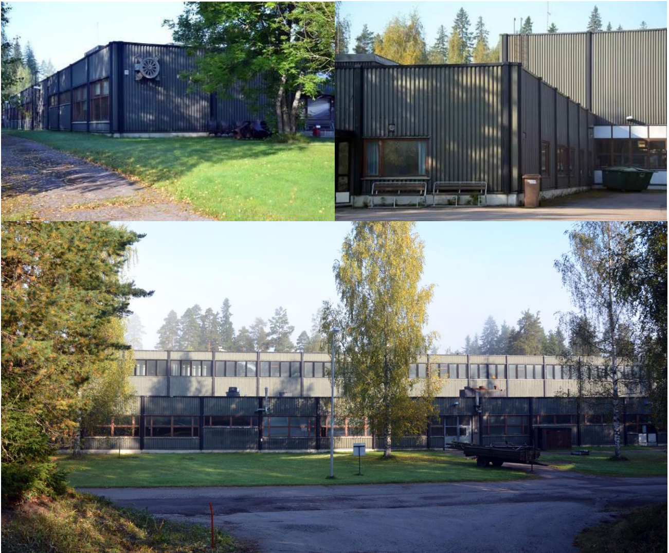
Kuvat: Kaakkoiskulma, itäjulkisivun sisäkulma ja eteläjulkisivu
