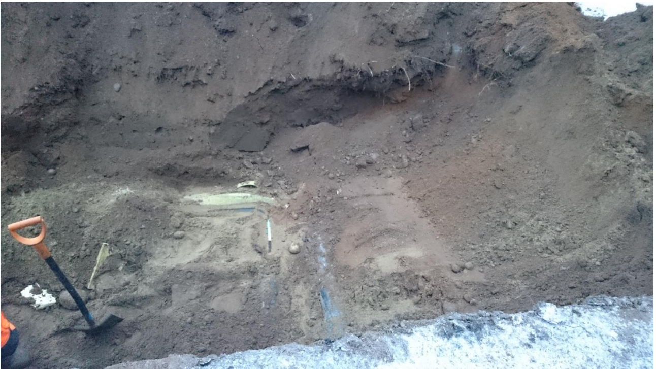
Kuva 3. Johdot ja putket alkavat erottua. Kuva: Eva Gustavsson
