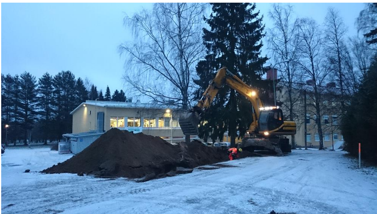
Kuva 1. Kaukolämpöjohdon etsintää. Taustalla Pälkäneen yhteiskoulu. Kuvattu kaakkoon. Kuva: Eva Gustavsson
