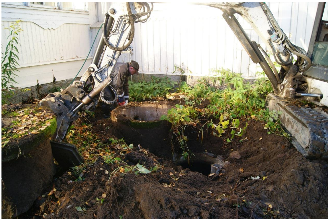
Kuva 2. Vanhojen jätevesikaivojen poistoa. Kuvattu itäkoillisesta. Kuva: Eva Gustavsson
