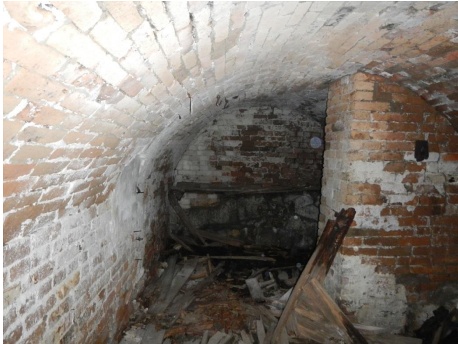
Kuva 18. Pehtoorintalon kellarin sisätiloja.
