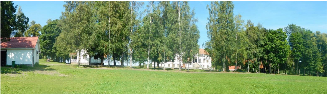
Kuva 1. Laukon kartanon päärakennus kuvattuna lounaispuoliselta pellolta.
