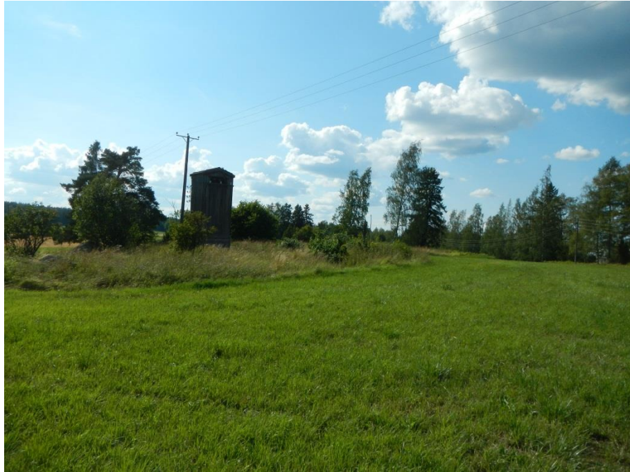
Kuva 31. Muuntajanmäellä havaittiin kivrakenteita, joiden sijaintitiedot merkittiin muistiin.
