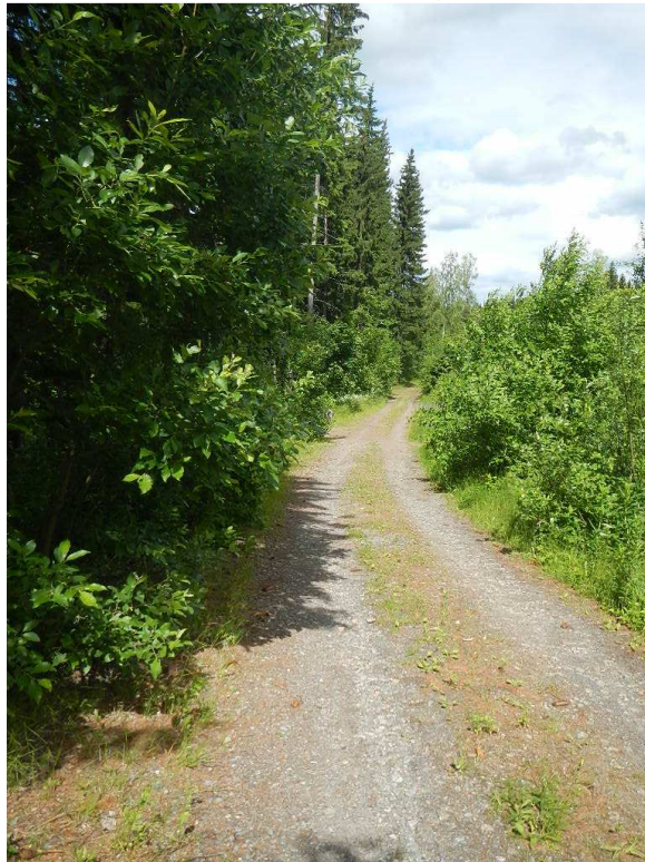
Kuva 24. Historiallinen tielinja Vanhan Ponsantien kohdalla. Maakaapelilinja on suunniteltu kulkevan tien vasemmassa eli länsireunassa. Kuvattu eteläkaakosta. (Kuva: Kangasala, Huutijärvi – Pispala 2014: 18).
