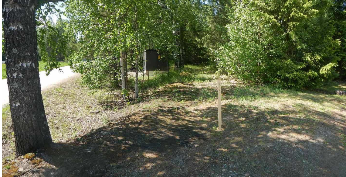
Kuva 28. Kuvassa keskellä vanha tielinjaus, jonka läpi paalulla merkitty maakaapelilinja kulkee. Kuvassa vasemmalla näkyy Laiska-Jaakontietä, oikealla omakotitalon pihatietä. Taustalla häämöttää vasta rakennettu puistomuuntaja. Kuvattu idästä. (Kuva: Kangasala, Huutijärvi – Pispala 2014: 20).
