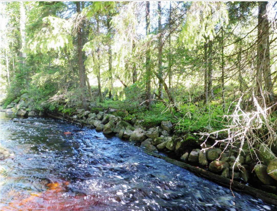
Kalliojärvenojan uittorakennetta. Kuva P. Jantunen.
