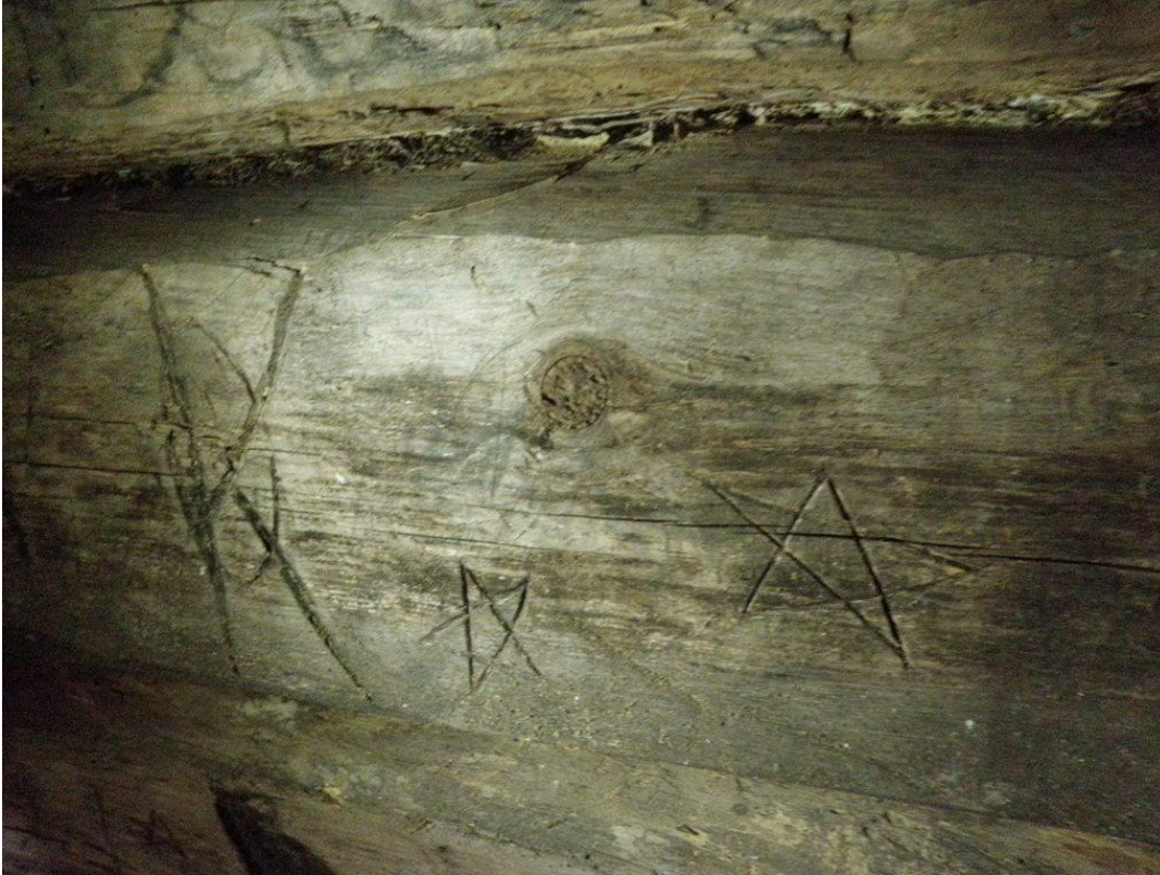
Kuva 7, myllyn sisäosan kaiveruksia.
