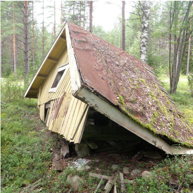
Lukonmaan rakennuksenjäännös. Kuva P. Jantunen.
