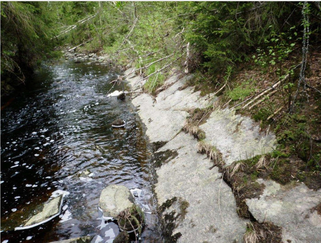
Kronstadtin kanavan kivrakennetta. Kuva V. Laurila.
