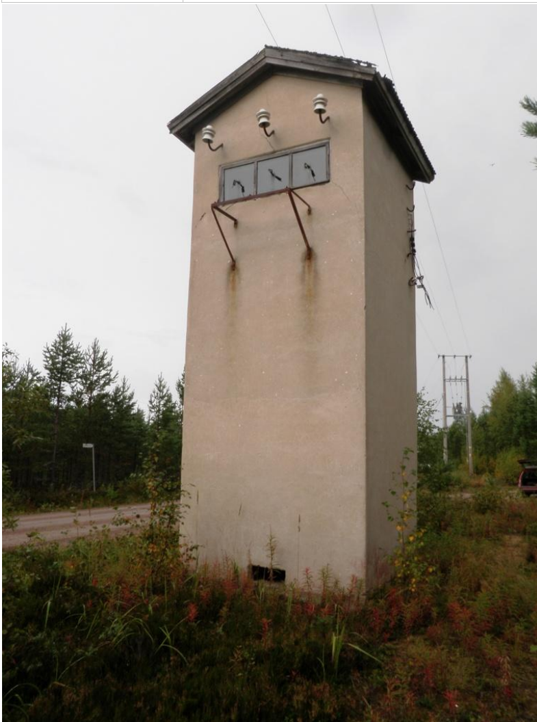
Ison Ristiharjunlammen muuntajatorni. Kuva P. Jantunen.
