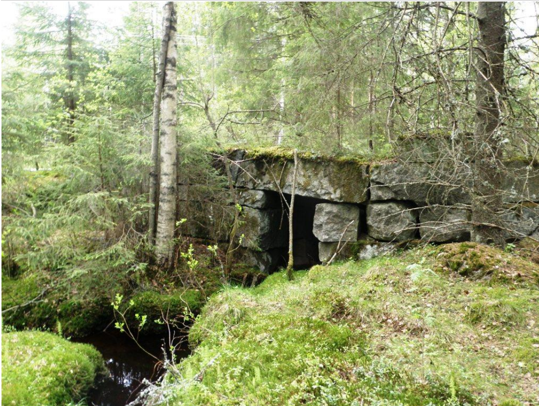
Heinäsuon maantiesilta. Kuva V. Laurila.
