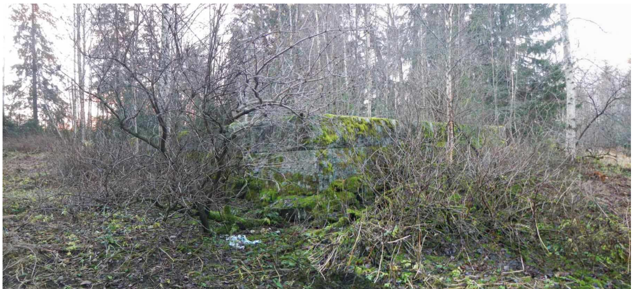
Kuva 43. Navetan kiviperustusta kuvattuna koillisesta. (KHH_täydennysinventointi 2013:16)
