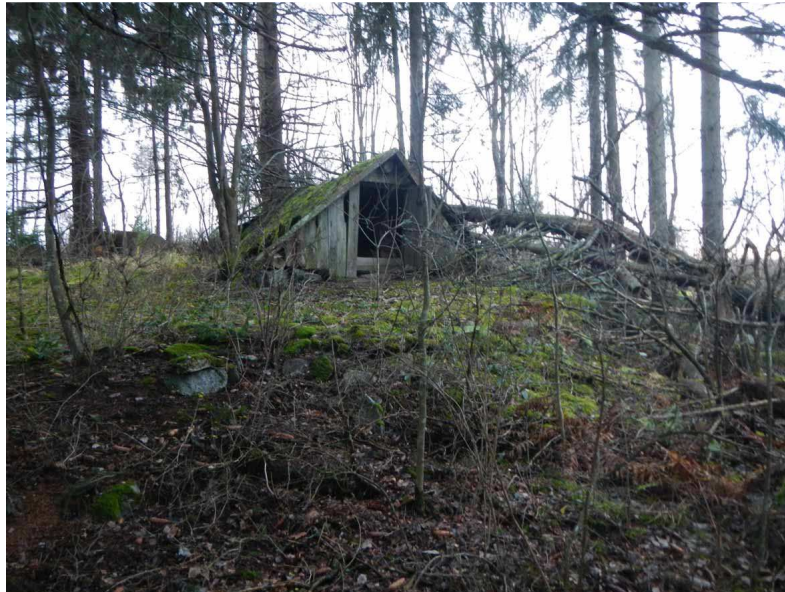
Kuva 46. Kellarin yhä pystyssä olevat maanpäälliset rakenteet. (KHH_täydennysinventointi 2013:19)
