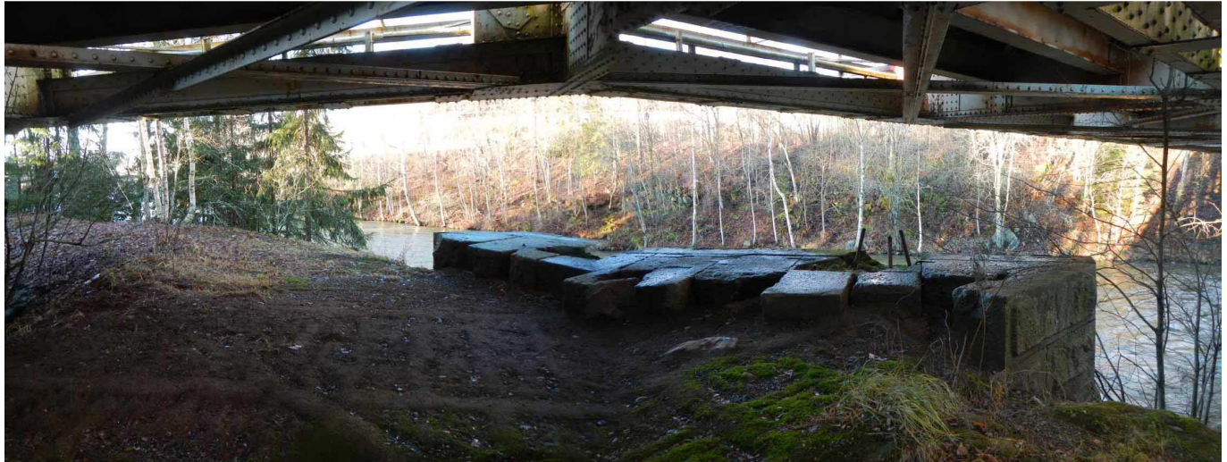
Kuva 9. Panoraamakuva vanhaan rautatiesiltaan liittyvästä rakenteesta. Kuvattu koillisesta. (KHH_täydennysinventointi 2013:1)
